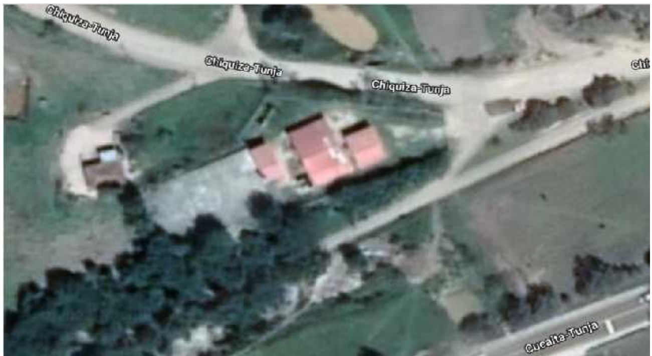
Ilustración 7. Vista aérea de la escuela
