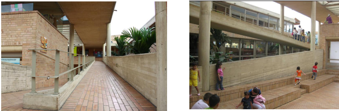
Figura 61. Fotografía rampa y patio interior Centro de Desarrollo Cultural Moravia
