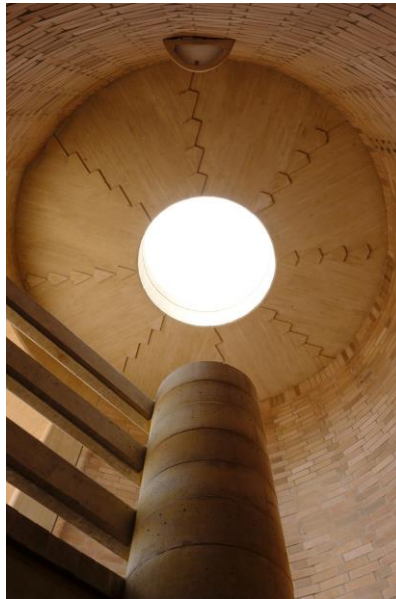
Figura 11. Fotografía interior óculo escalera
