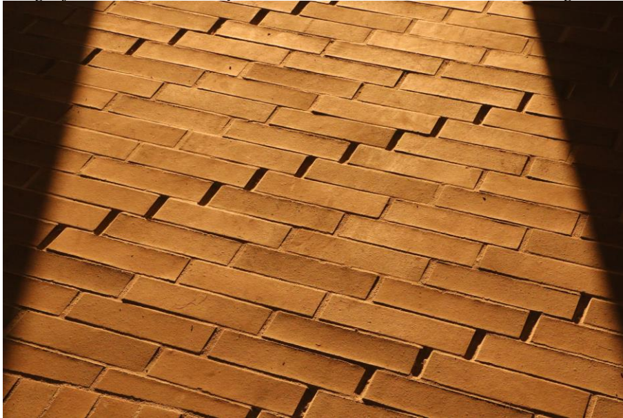
Figura 19. Fotografía de acabado de piso: Centro cultural universitario Rogelio Salmona
