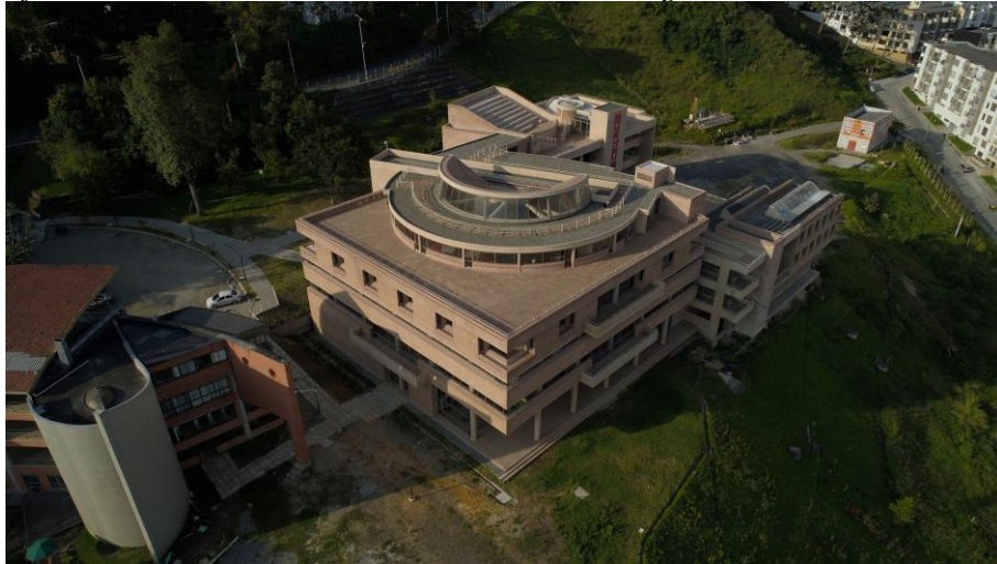
Figura 6. Fotografía exterior: Centro cultural universitario Rogelio Salmona
