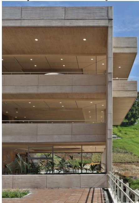
Figura 22. Fotografía exterior desde patio interno hacia fachada
