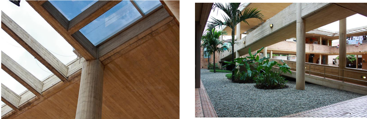
Figura 60. Fotografía estructura y rampa Centro de Desarrollo Cultural Moravia
