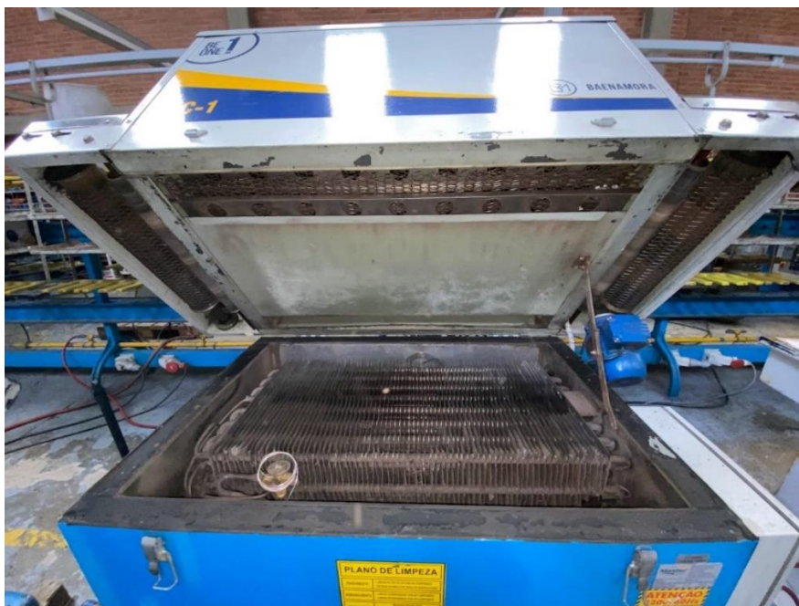
Fig. 30. Evaporador de Chiller CC-1
