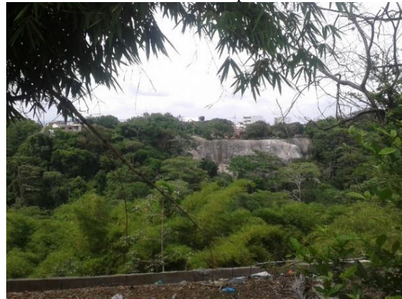
Figura 8. Carrera 11 O # 30 Control de erosión Fuente: Propia
