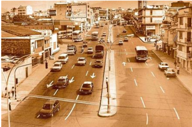
Figura 47. Avenida quebrada seca (Antes)
