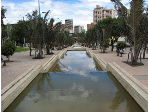
Figura 63: Caida de agua de la canalización del Rio
