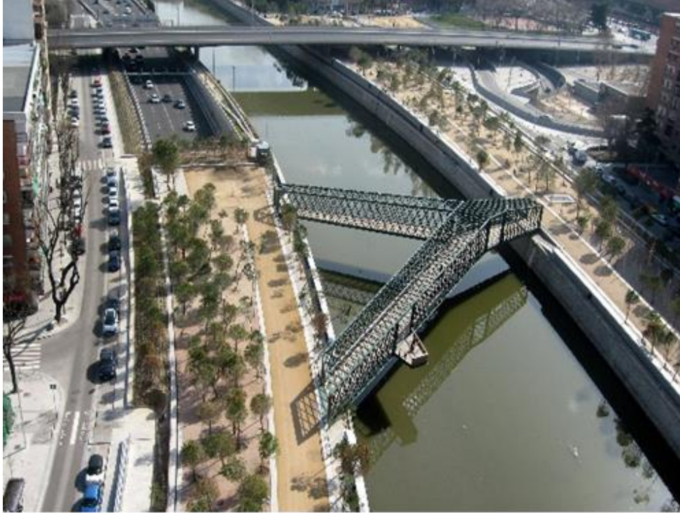
Figura 74: Puente en forma de Y
