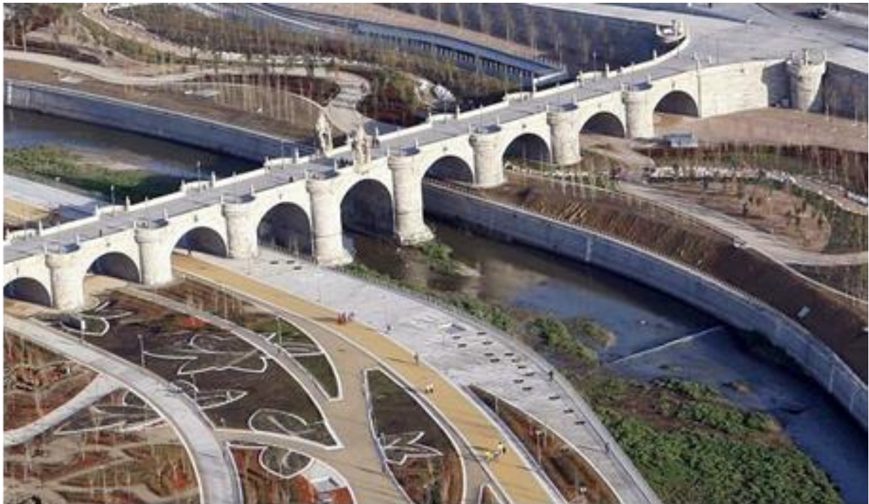
Figura 76: Puente de Segovia
