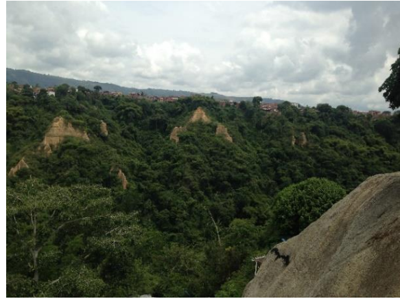
Figura 12. Carrera 18 O # 36 Control de taludes Fuente: Propia
