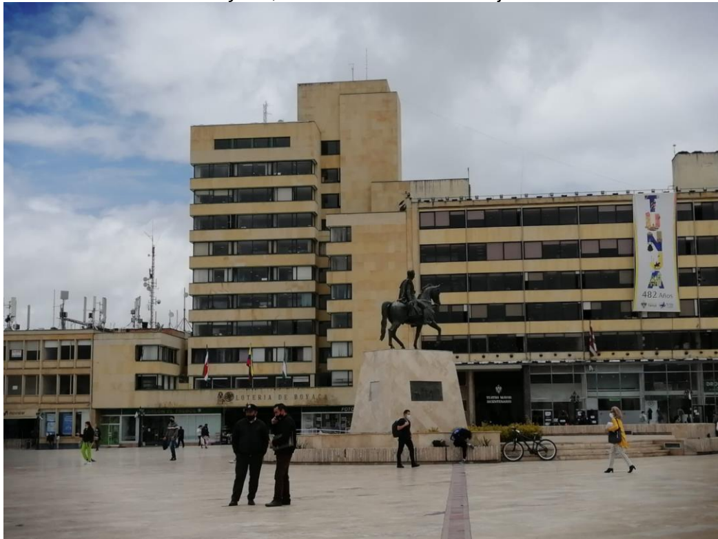
Figura 2 Edificio Lotería de Boyacá, Plaza de Bolívar en Tunja
