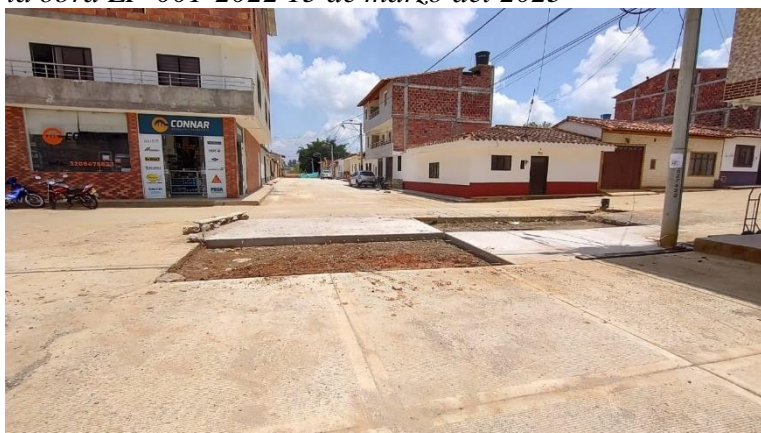
Figura 20. Visita a la obra LP-001-2022 15 de marzo del 2023
