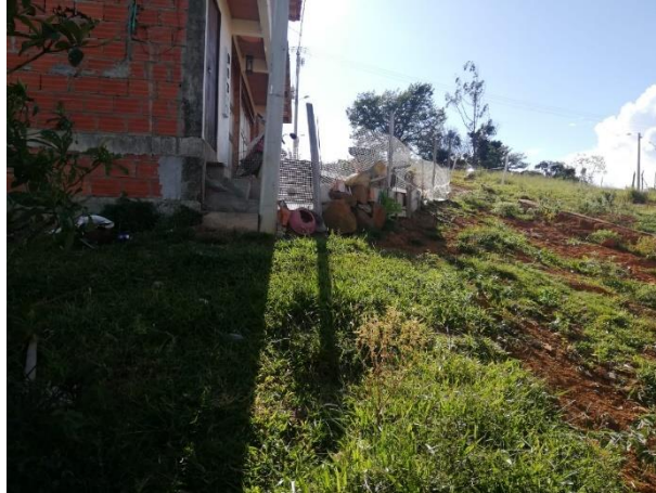
Figura 37. Visita realizada por la obstrucción de la vía pública.
