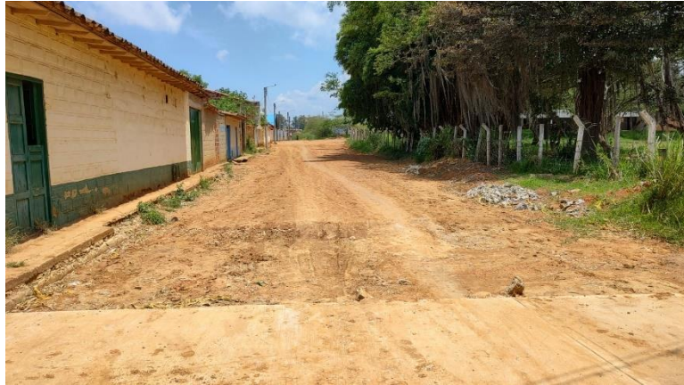
Figura 22. Visita a la obra LP-001-2022 15 de marzo del 2023
