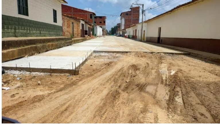
Figura 21. Visita a la obra LP-001-2022 15 de marzo del 2023
