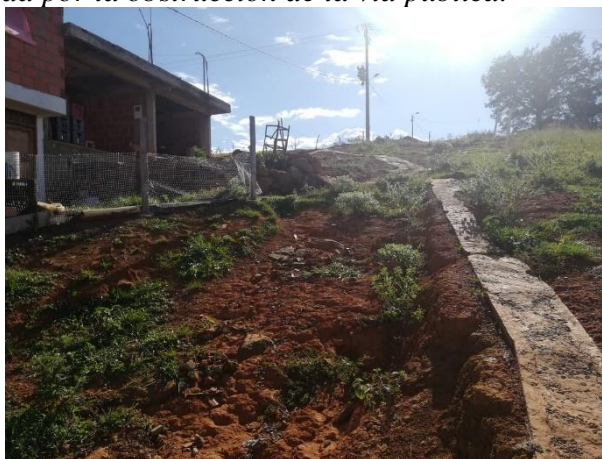
Figura 36. Visita realizada por la obstrucción de la vía pública.
