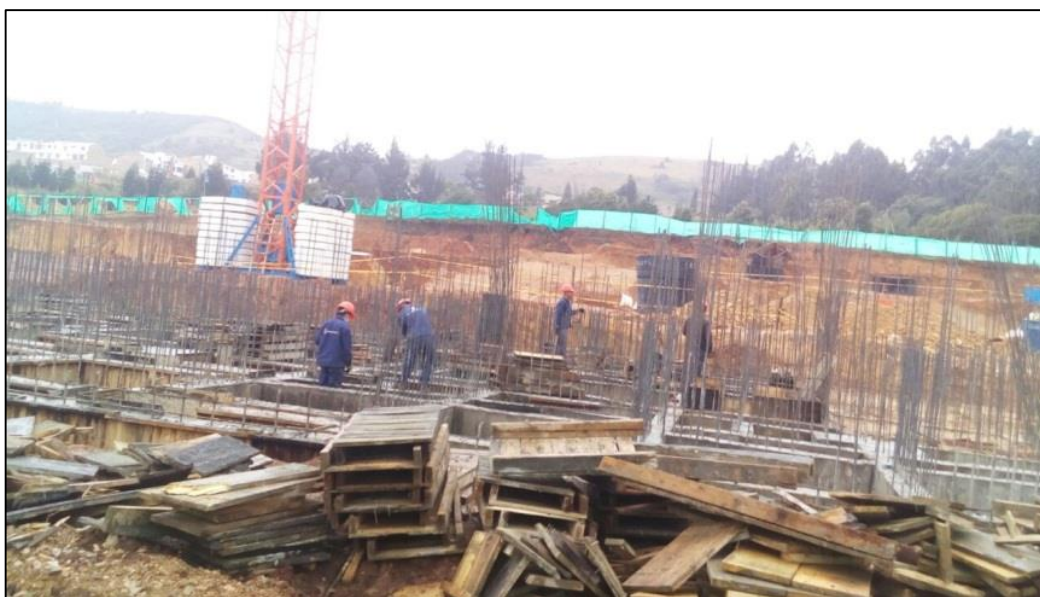
Figura 39 Desencoframado de vigas de cimentación de la primera fundida (Eje 15 – Eje 9), Torre 2.
