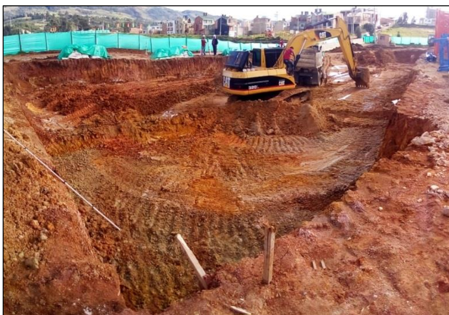
Figura 11 Excavación en terraza de la Torre 2.
