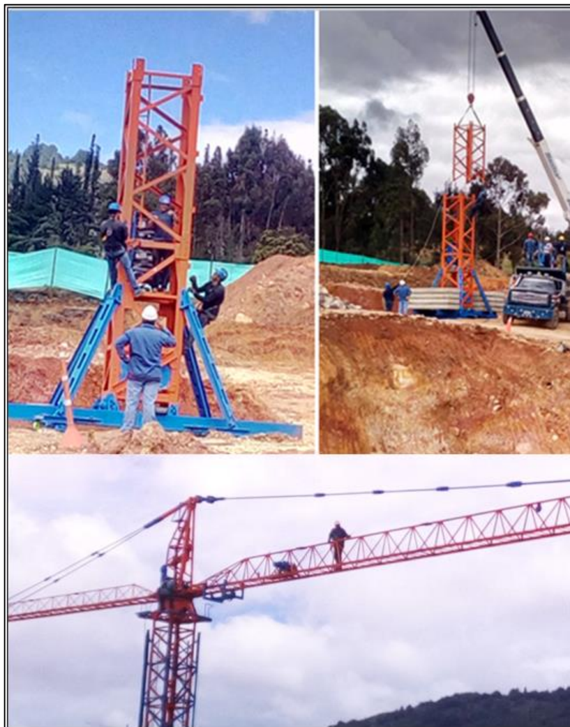
Figura 19 Montaje e instalación de Torre Grúa
