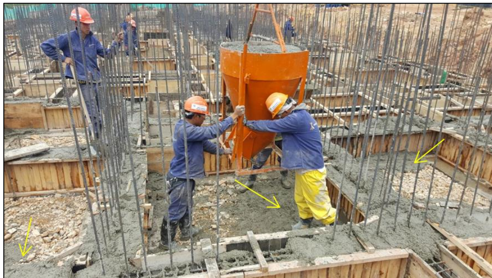
Figura 38 Vaciado del concreto con ayuda de la tolva y la torre grúa.
