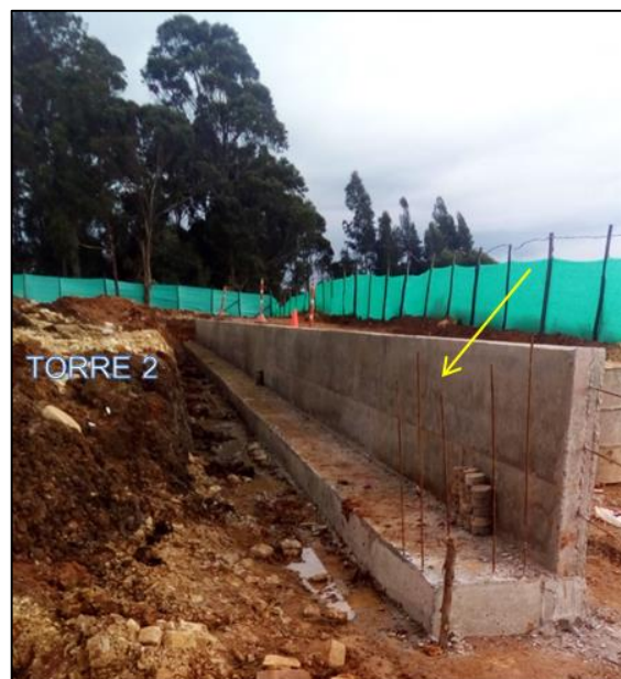
Figura 10 Muro de contención 2.
