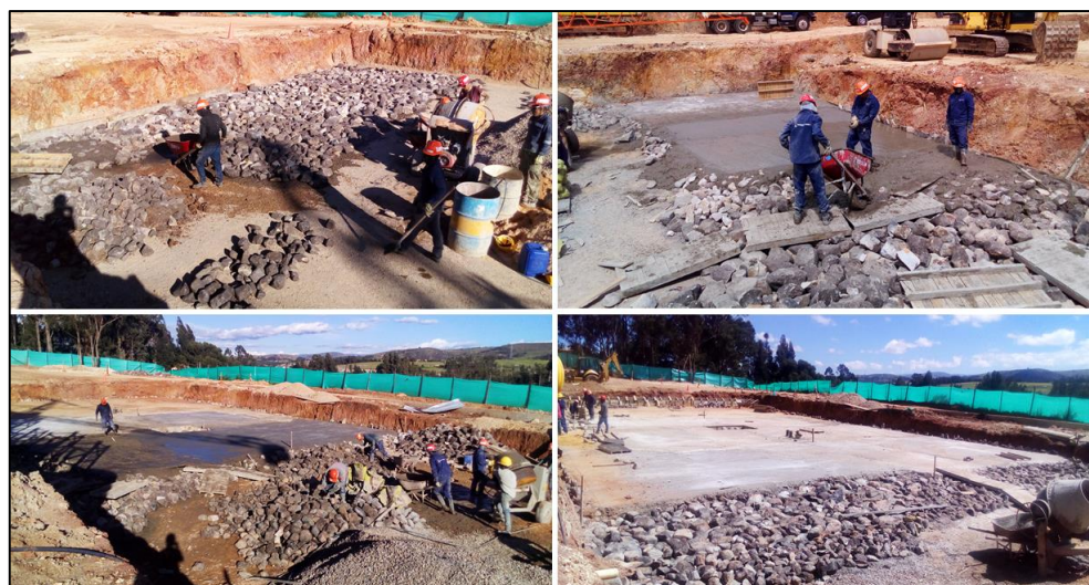
Figura 20 Construcción de placa de concreto ciclópeo (0,30 m de espesor) – Torre 2.
