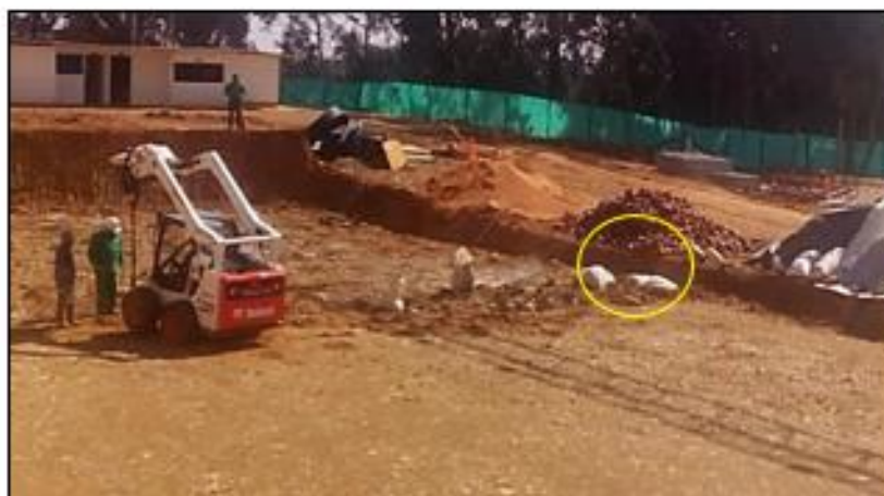
Figura 30 Formación de gases por reacción entre el agua y la cal viva en una de las perforaciones.
