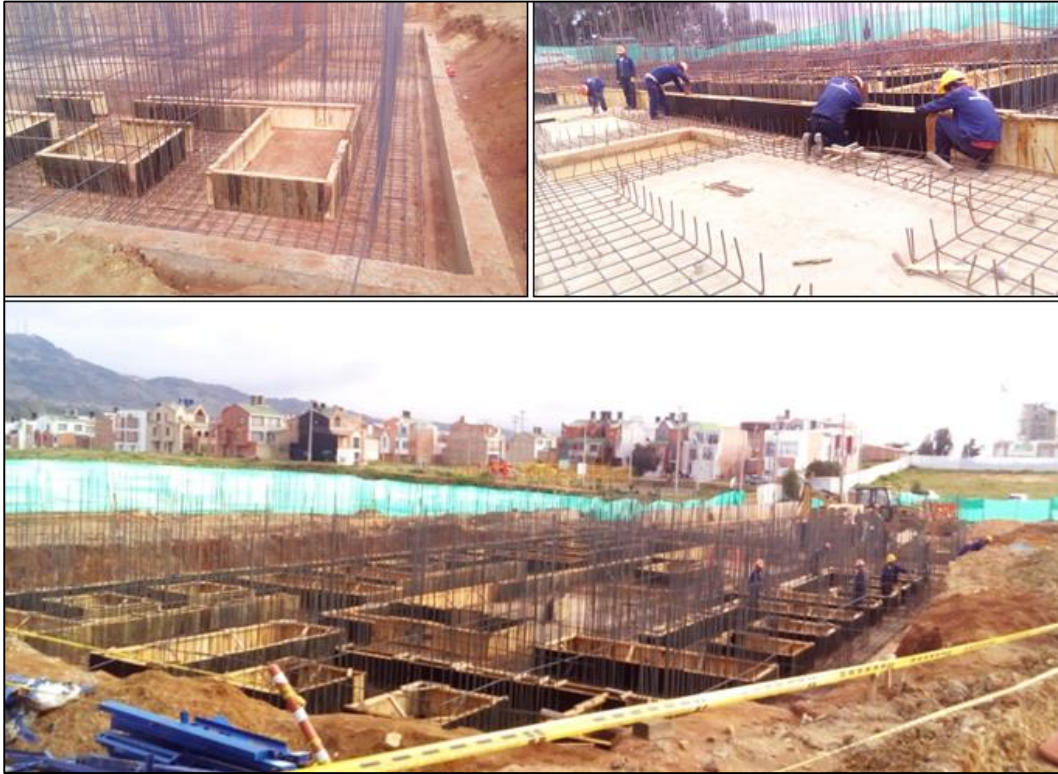
Figura 32 Instalación de formaleta en madera para fundir las zarpas – Torre 2.
