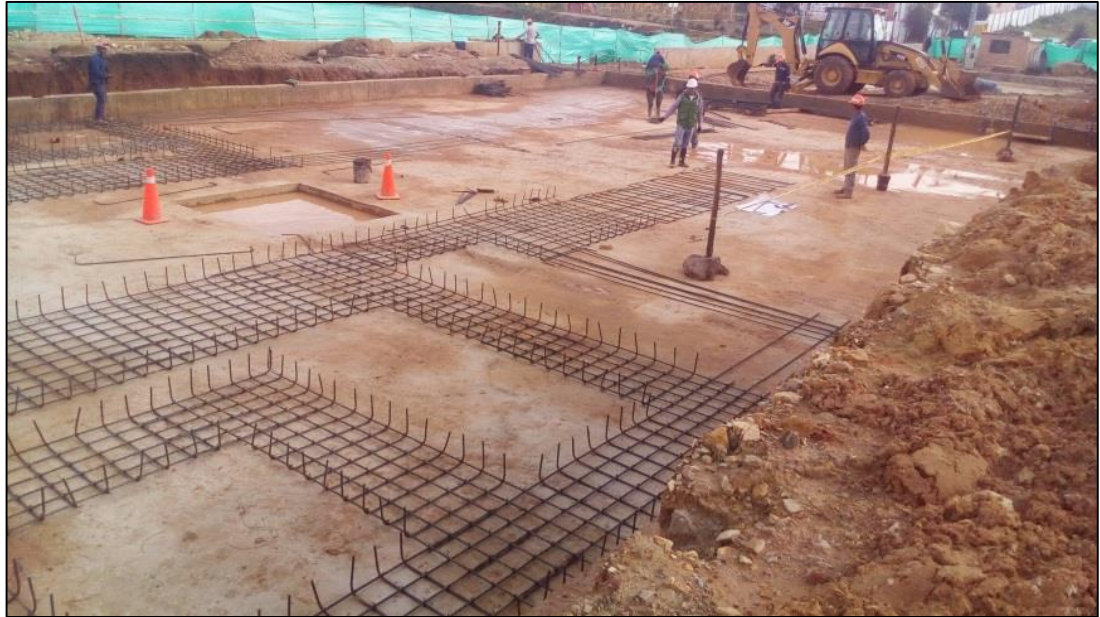
Figura 31 Figuración y amarre de acero para zarpas – Cimentación Torre 2.
