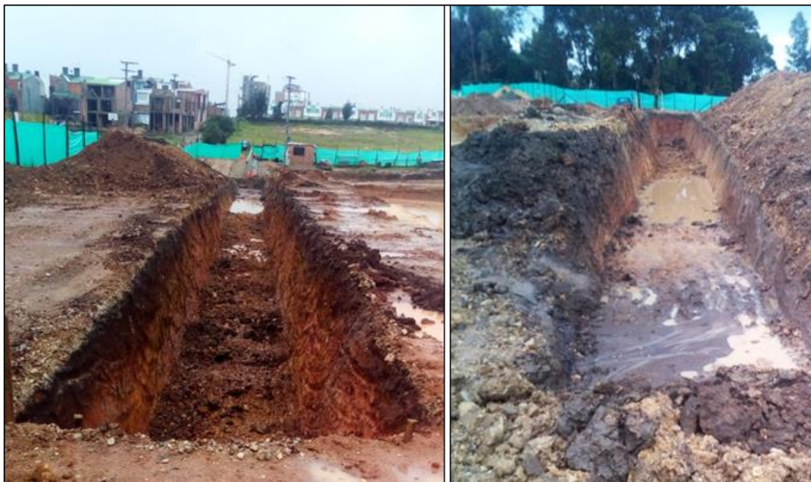
Figura 8 Excavación para muro de contención 2.
