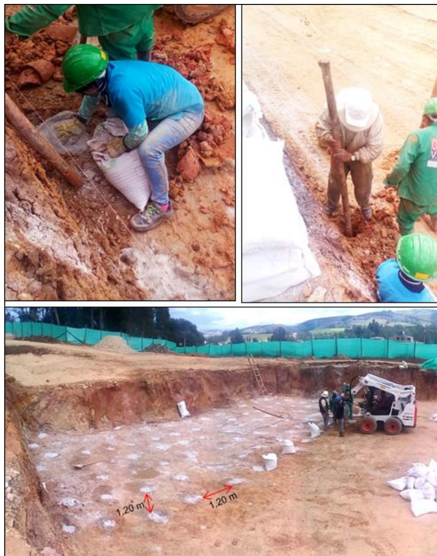
Figura 12 Mejoramiento de suelo con micro pilotes de cal, Torre 2.
