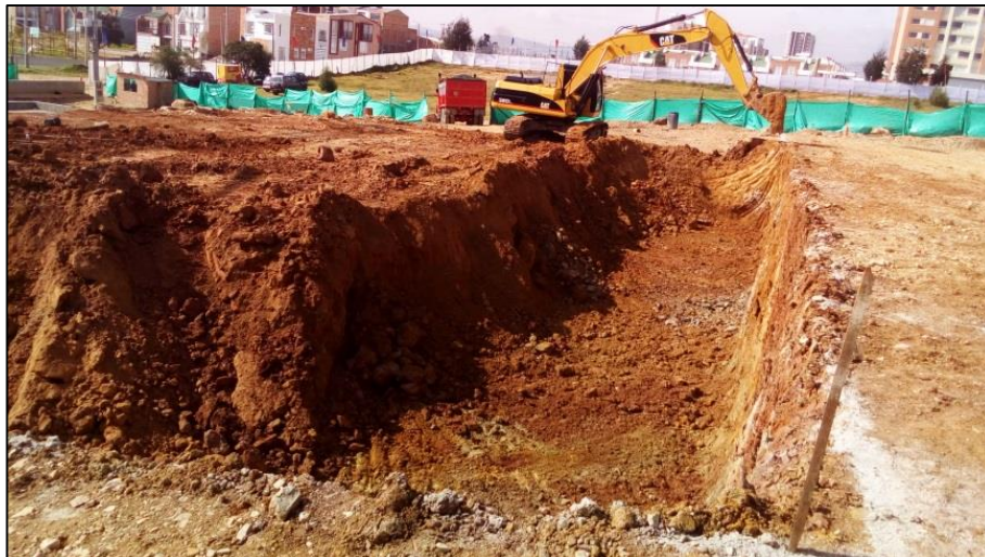
Figura 28 Excavación y retiro de material en la torre 3.
