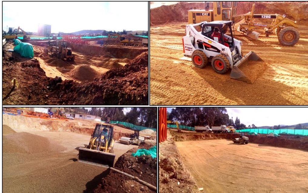
Figura 17 Extendida y compactación de las capas de base y sub base – Torre 2.
