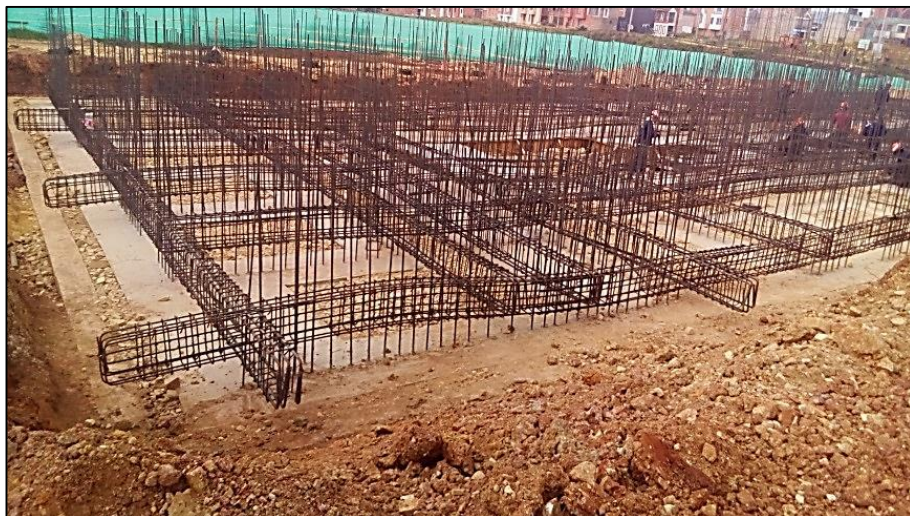
Figura 36 Figuración y amarre de vigas de cimentación, Torre 2.
