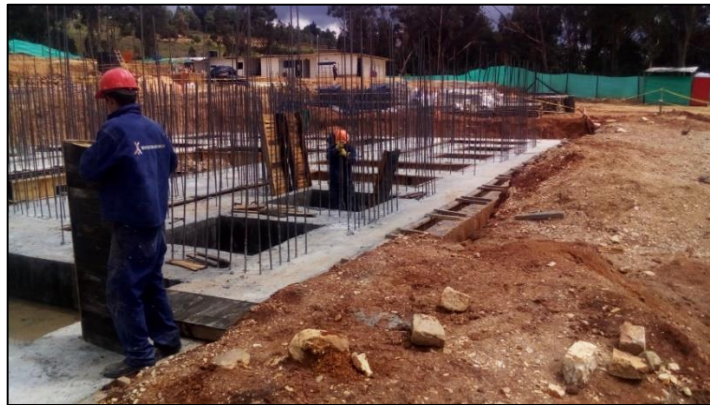
Figura 34 Retiro de formaleta de zarpas - Torre 2.
