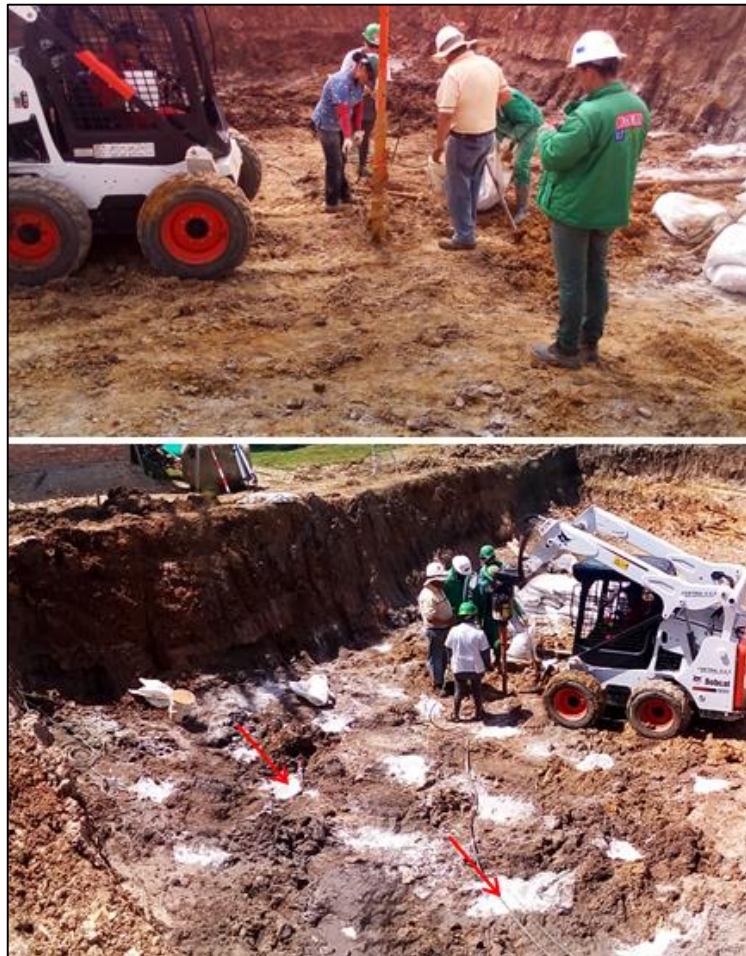
Figura 16 Micro pilotes de cal en la zona A.
