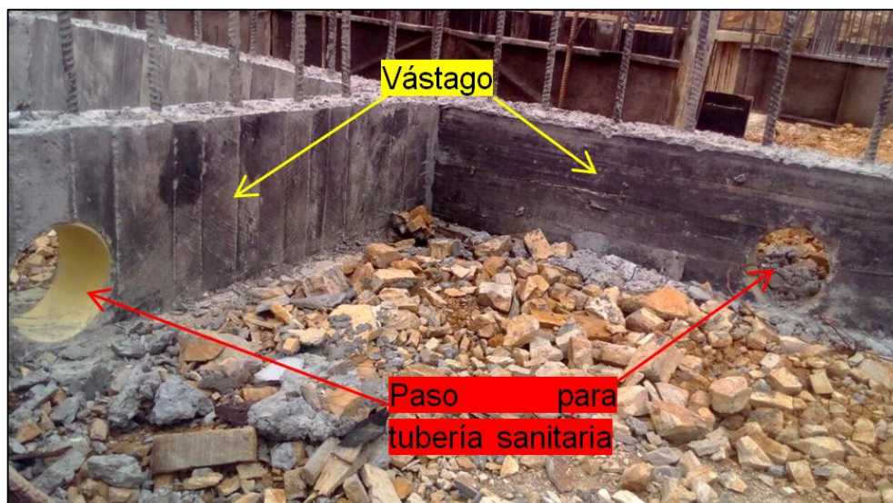
Figura 41 Vástago para el paso la red hidrosanitaria.
