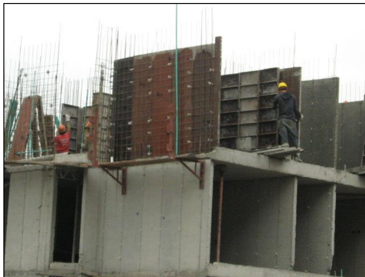
Figura 6 Sistema Constructivo Tipo Túnel o Contech
