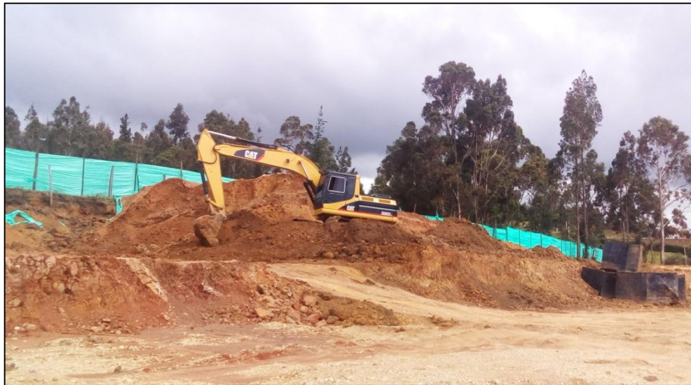
Figura 23 Retiro mecánico de material granular suelto en terraza de la torre 6
