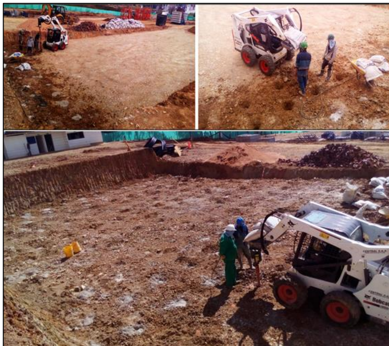
Figura 29 Perforación de micro pilotes en la Torre 4.
