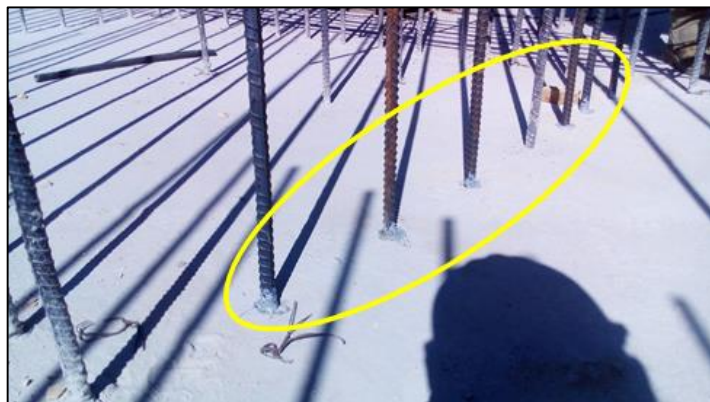
Figura 35 Adición de aceros de anclajes de cimentación con epóxico Sika.
