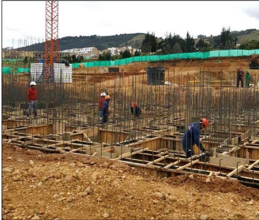
Figura 37 Instalación de formaleta para vigas de cimentación de la primera fundida (Eje 15 – Eje 9), Torre 2.
