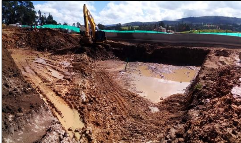
Figura 14 Excavación y retiro de material de depósito arcillo limoso en la Terraza de la Torre 1
