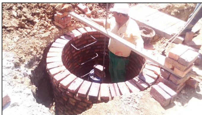
Figura 27 Construcción de pozos de inspección
