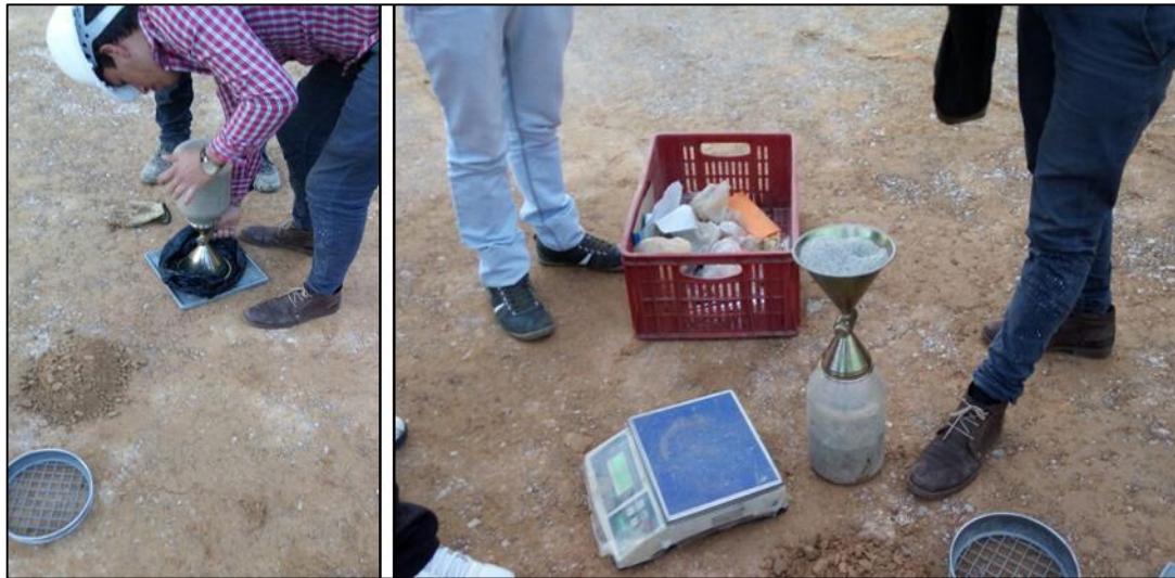
Figura 18 Ensayo cono de arena de la capa de subbase – Torre 2.
