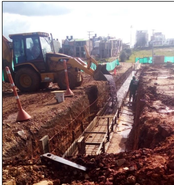
Figura 9 Vaciado de concreto para muro de contención 2
