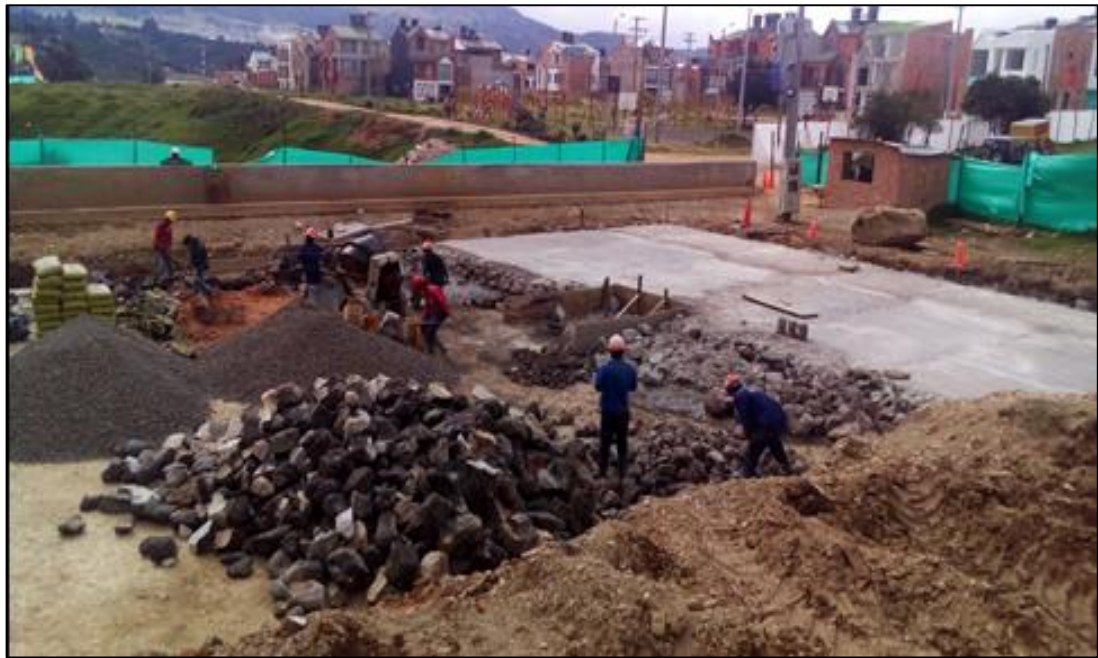
Figura 24 Construcción de la capa de concreto ciclópeo, e=0,50 m.
