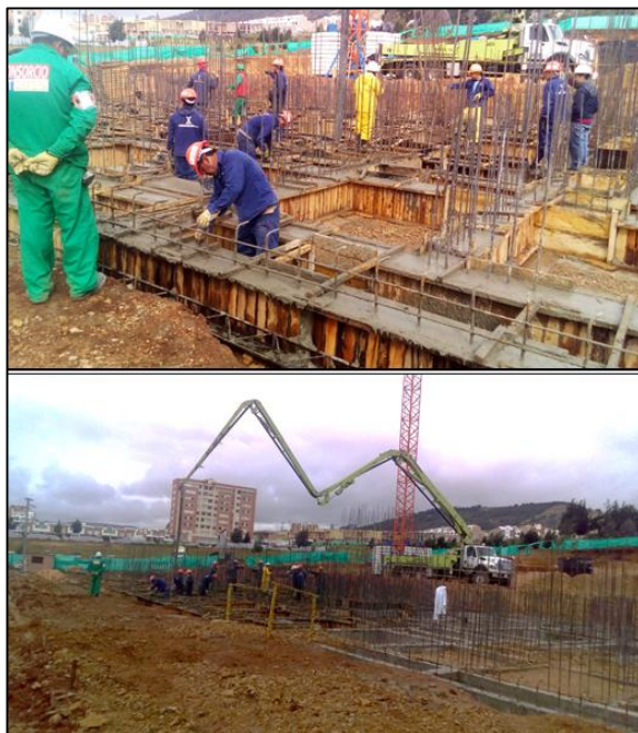
Figura 40 Vaciado de concreto para la segunda parte de las vigas de cimentación (Eje 9 – Eje 1), Torre 2.
