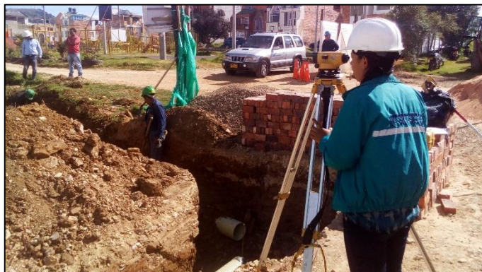
Figura 26 Rectificación de niveles para red de alcantarillado pública.
