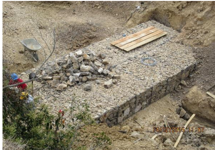
Figura 25. Construcción 1er nivel del gavión
