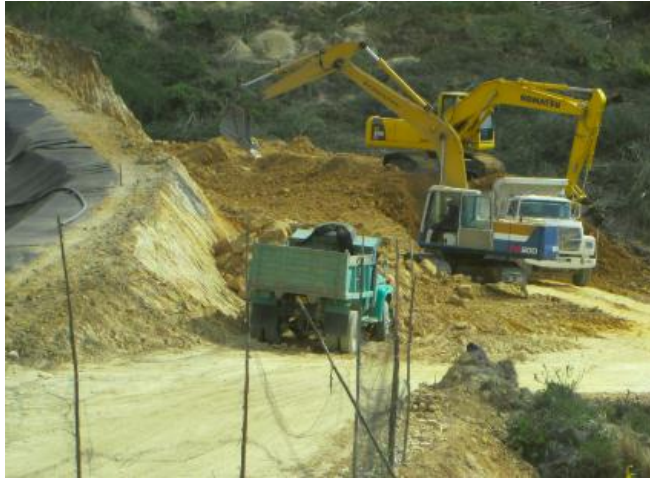
Figura 13. Perfilado talud de la terraza 4
