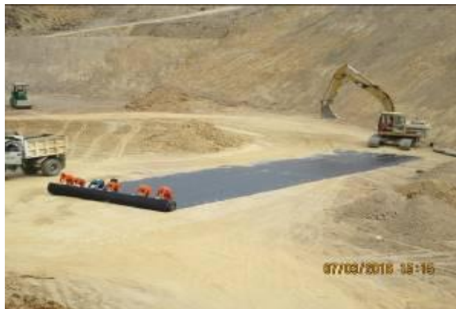
Figura 47. Corte de geomembrana para impermeabilización terraza 1
