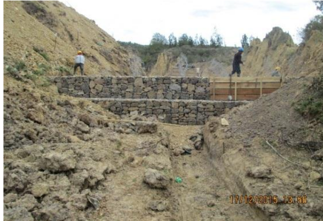
Figura 26. Construcción 2º nivel del gavión
