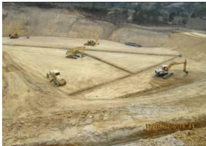
Figura 52. Excavación zanjas para filtro de fondo en terraza 1
