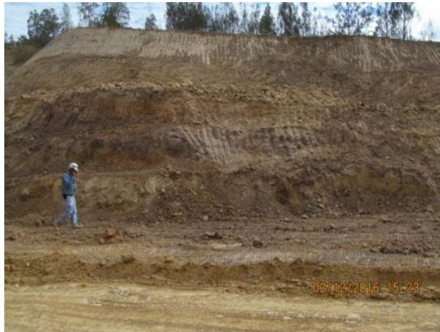
Figura 38. Escalonamiento del talud sur de la terraza 1
