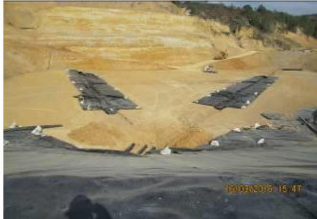
Figura 53. Geomembrana en zanjas para instalación de filtros de fondo
