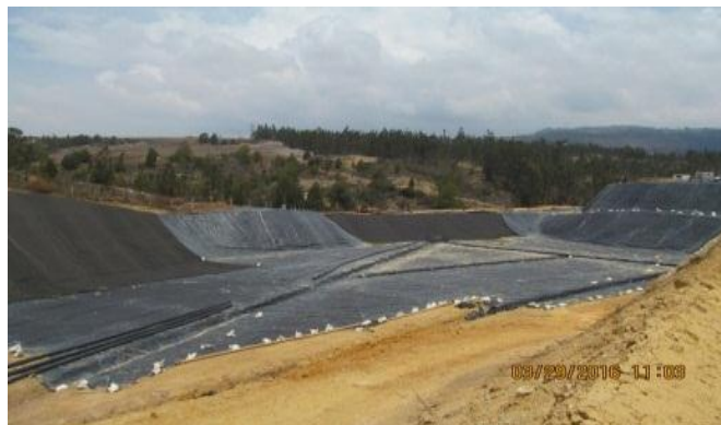
Figura 49. Instalación de geotextil NT2000 en la terraza 1
