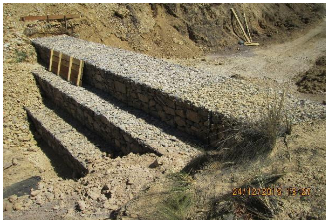
Figura 27. Finalización 3er nivel del gavión
