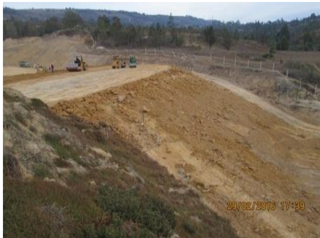
Figura 46. Construcción del dique llegando a una altura de 7,83m.
