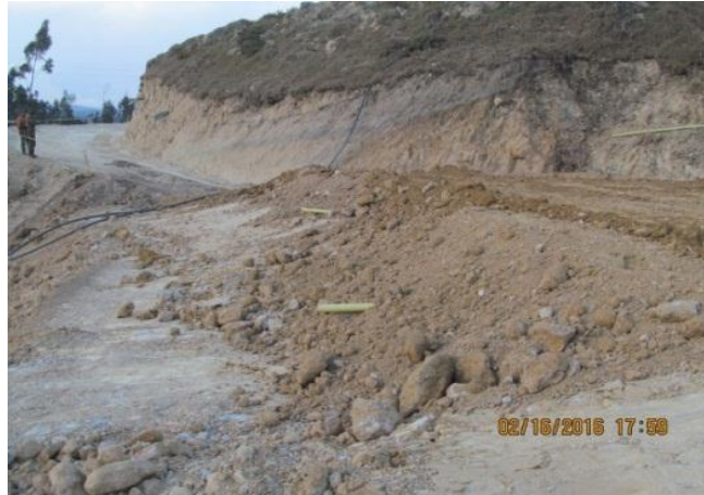
Figura 45. Drenes del dique en cota 2653.5 m.s.n.m.
