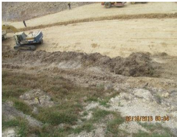
Figura 40. Escalonamiento del talud Norte del dique
