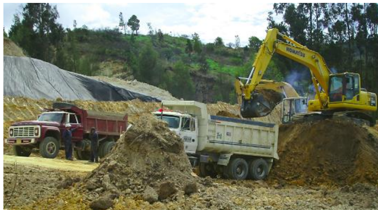
Figura 12. Excavación de arcilla en la terraza 4
