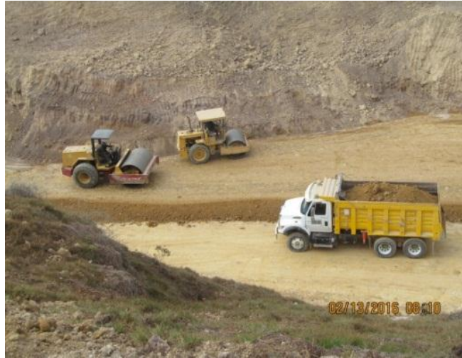
Figura 43. Compactación de arcilla-recebo (70-30) para el dique.
