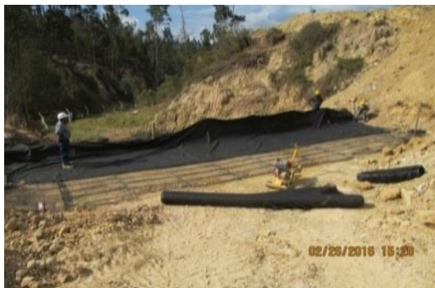
Figura 59. Capa de geo-malla y geo-textil en el muro de tierra armada.
