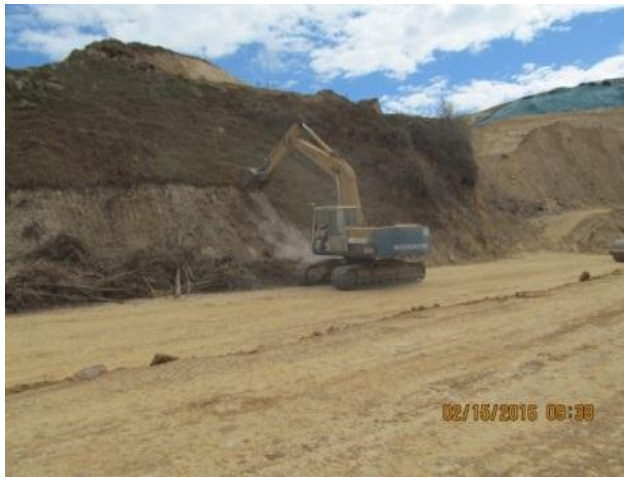
Figura 39. Descapote para escalonamiento del talud Norte del dique
