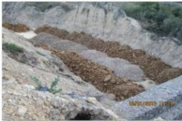
Figura 34. Mezclado y extendido de arcilla recebo en pondaje A y dique
