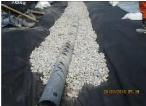
Figura 55. Perforación con motosierra tubería Polietileno
