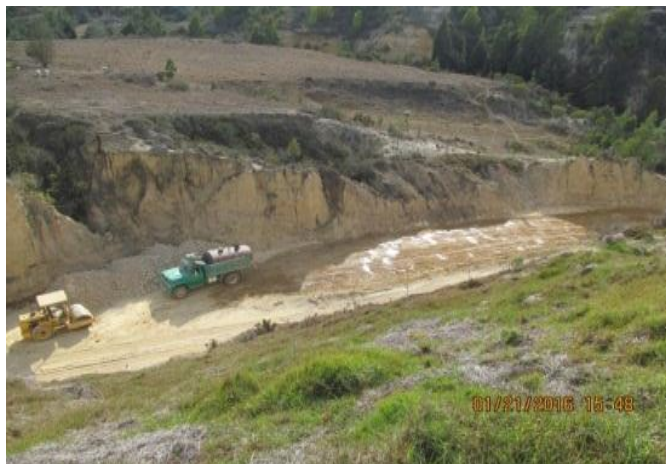
Figura 37. Humectación y compactación de la mezcla arcilla – recebo
