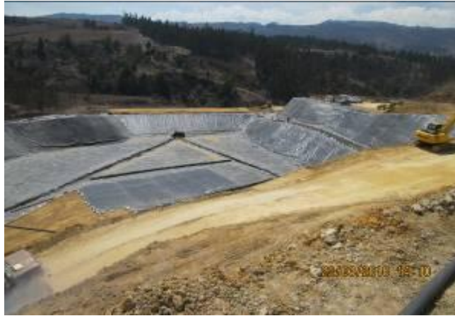
Figura 48. Instalación geomembrana en la terraza 1
