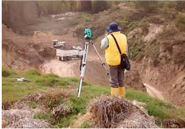
Figura 11. Ubicación topográfica de los puntos de las terrazas
