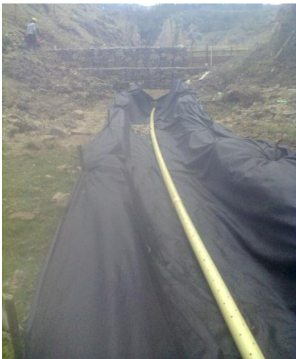
Figura 30. Construcción del filtro francés
