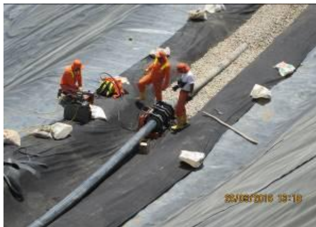
Figura 56. Pegue tubería Polietileno 8" para filtros de fondo
