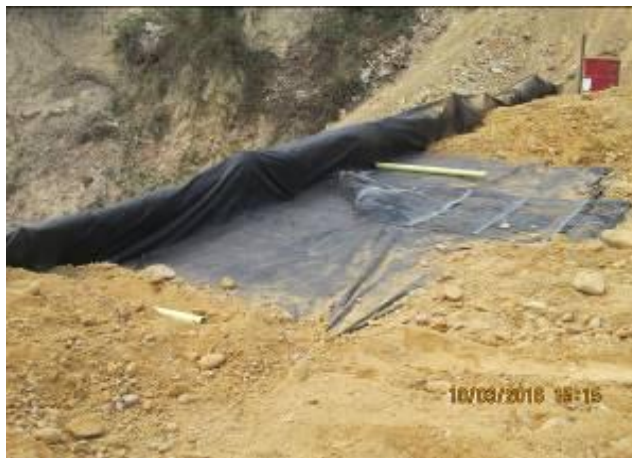
Figura 62. Instalación de drenes en el muro en tierra armada
