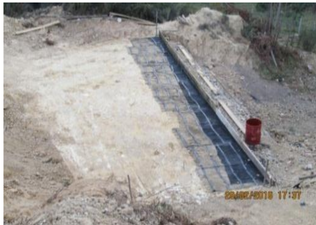
Figura 61. Recubierta mezcla arcilla recebo con geomalla y geotextil
