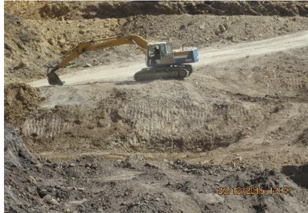
Figura 16. Excavación y perfilado terraza 2
