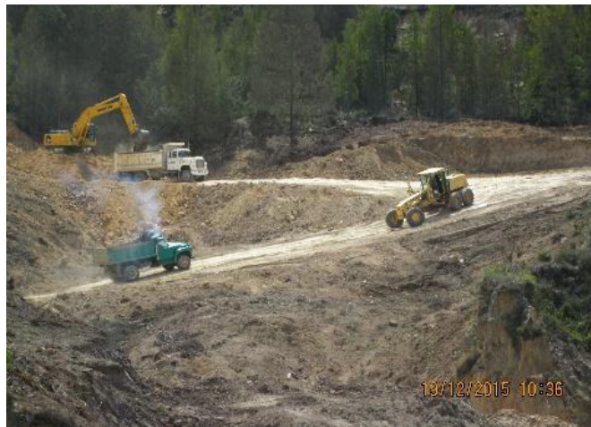
Figura 15. Perfilado de la vía provisional entre las terrazas 3 y 2
