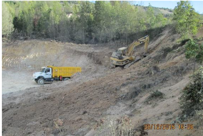
Figura 14. Excavación terrazas 3 y 2
