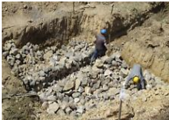
Figura 22. Piedra rajón para mejoramiento del suelo
