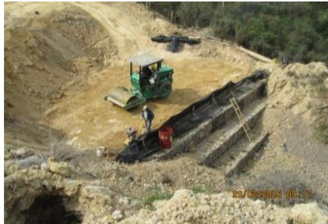
Figura 60. Primera capa de mezcla arcilla-recebo en muro de tierra armada
