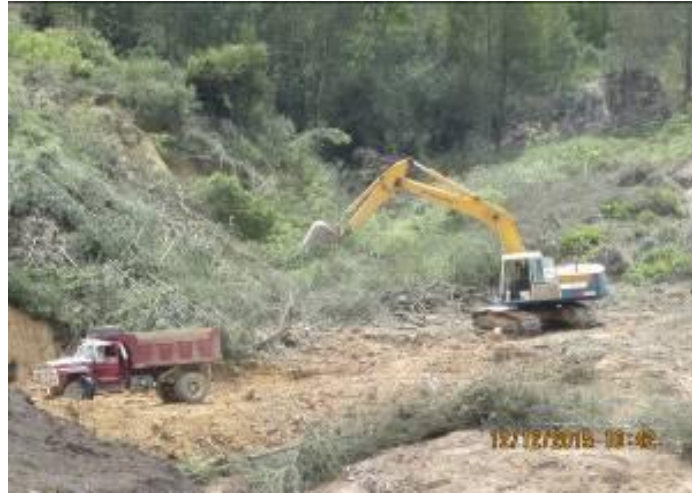
Figura 10. Descapote y cargue de material en terrazas 2 y 3
