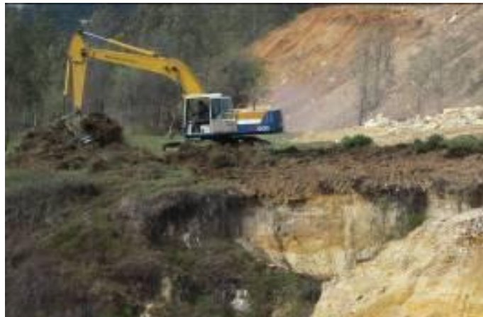
Figura 8. Descapote terreno
