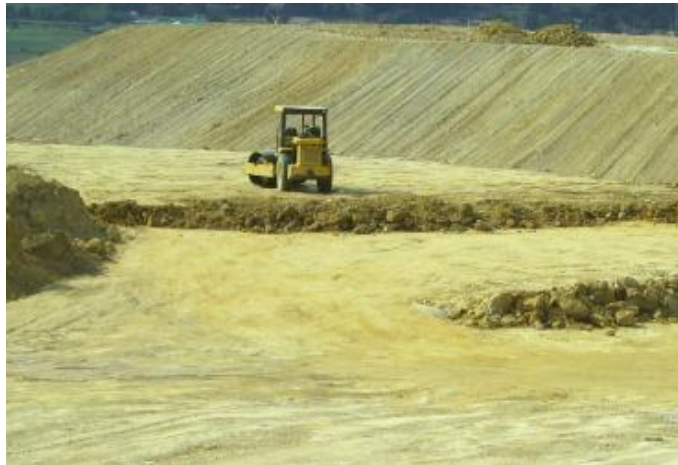
Figura 4. Explanación y compactación en el acopio
