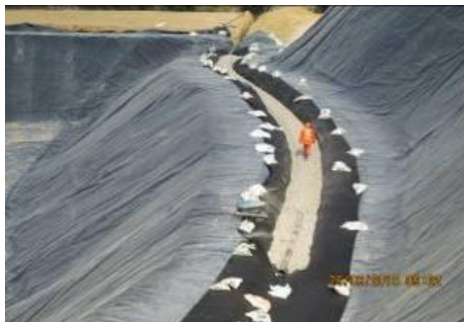
Figura 54. Extendido de grava en zanja de filtros de fondo
