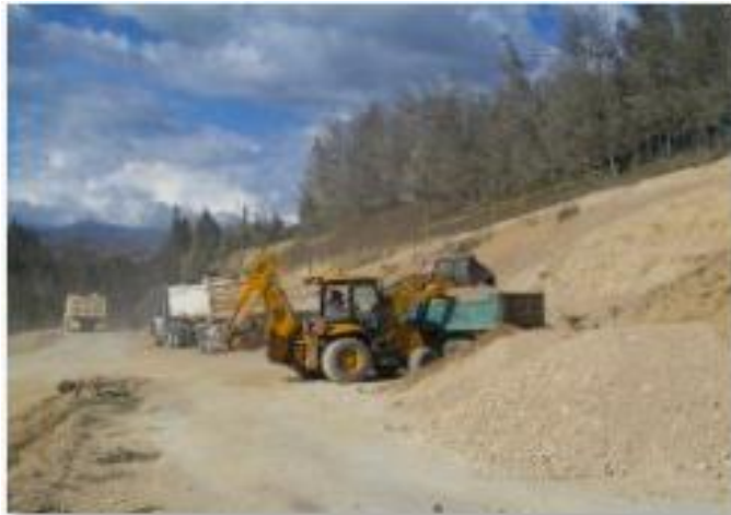
Figura 33. Recebo para el mejoramiento del suelo en pondaje A y dique
