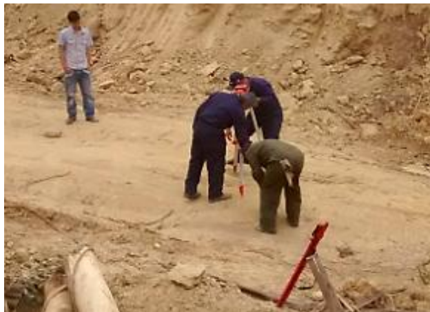
Fotografía 1. Nivelación de la cota en la terraza 1
