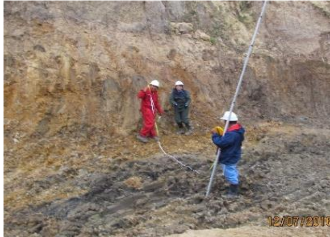
Figura 19. Medición del mejoramiento del suelo pondaje A y dique
