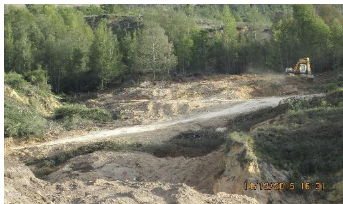
Figura 9. Descapote terraza 2
