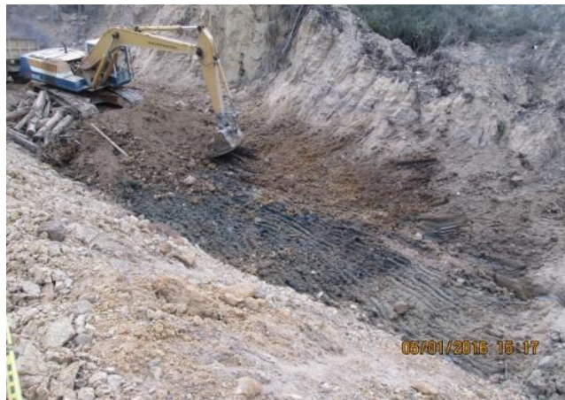
Figura 18. Mejoramiento en zona del pondaje A y dique
