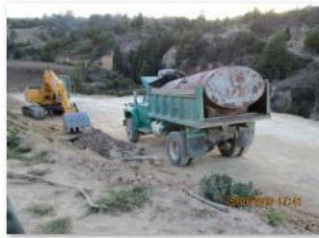
Figura 36. Tanque para humectación de la mezcla arcilla – recebo
