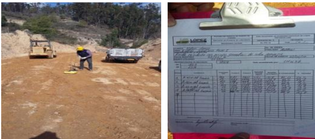
Figura 35. Toma de densidades mezcla arcilla- recebo
