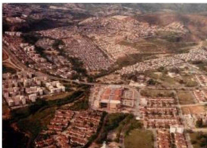
Figura 46. Vista general año 1990
