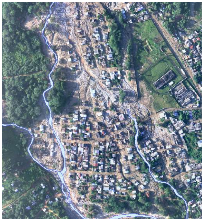
Figura 6 Patrón de drenaje cauce principal
