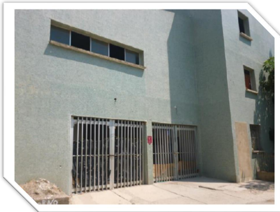
Fotografía 10. Acceso de ambulancias/ urgencias. Fuente Propia
