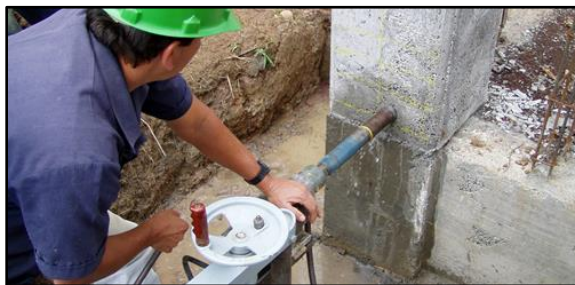
Fotografía 34. Ejemplo extracción de núcleos en columnas
