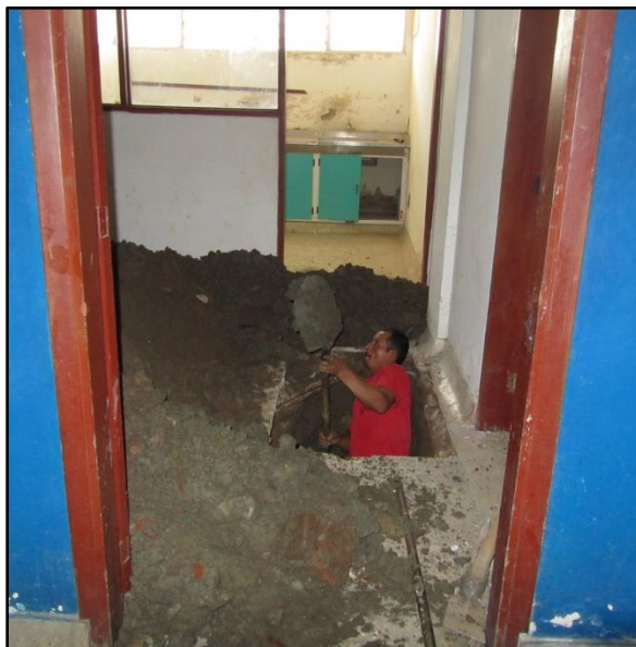
Fotografía 33. Excavación para constatar el estado de la cimentación existente. Fuente Propia
