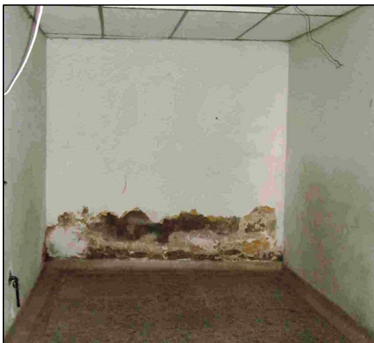
Fotografía 11. Deterioro de las paredes y pérdida del revoque por acción del agua. Fuente Propia
