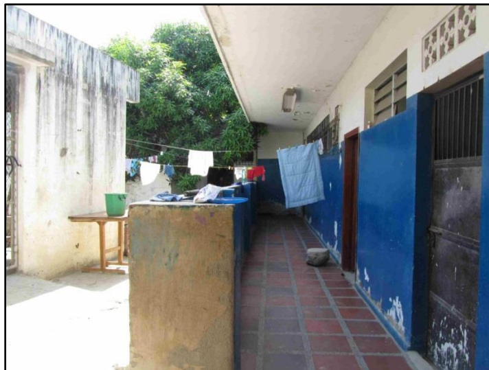
Fotografía 11. Deterioro de las paredes y pérdida del revoque por acción del agua. Fuente Propia
