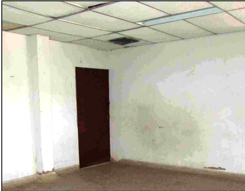
Fotografía 13. Perdida del recubrimiento del acero debido a esfuerzos mecánicos. Fuente Propia
