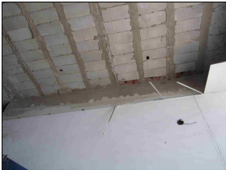
Fotografía 1. Vista inferior losa aligerada nivel 2. Fuente Propia
