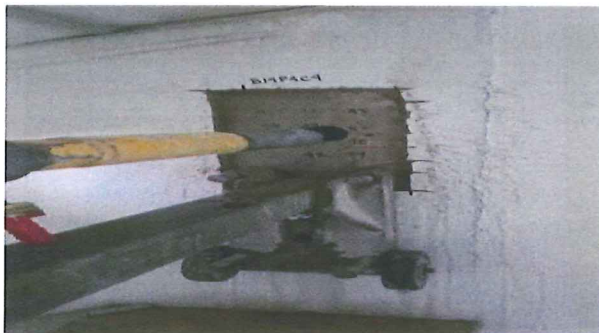
Ilustración 1/1. Extracción de núcleo
