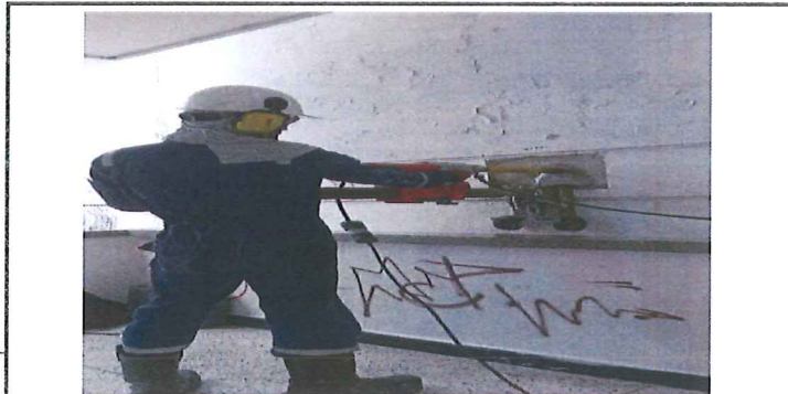
Ilustración 1/1. Extracción de núcleo
