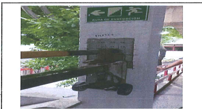
Ilustración 1/1. Extracción de núcleo
