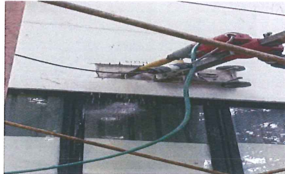
Ilustración 1/1. Extracción de núcleo
