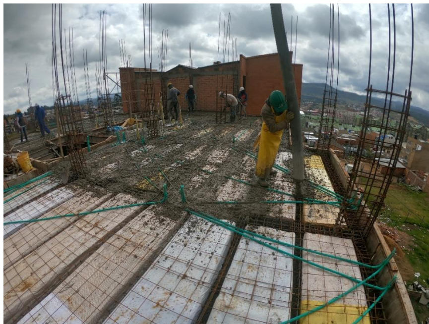
Imagen 30: Fundida de vigas y viguetas
