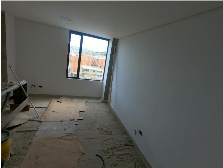
Imagen 19: Acabados de muro adicionales
