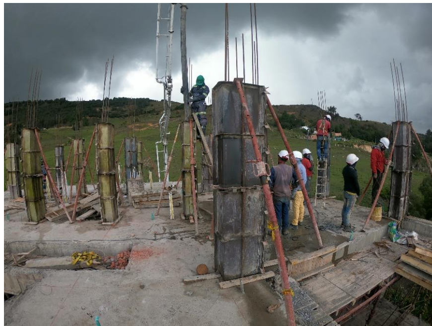
Imagen 27: Fundida de columnas
