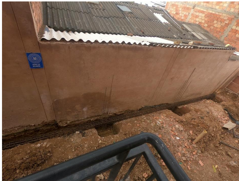
Imagen 39: Cimentación de muro de cerramiento
