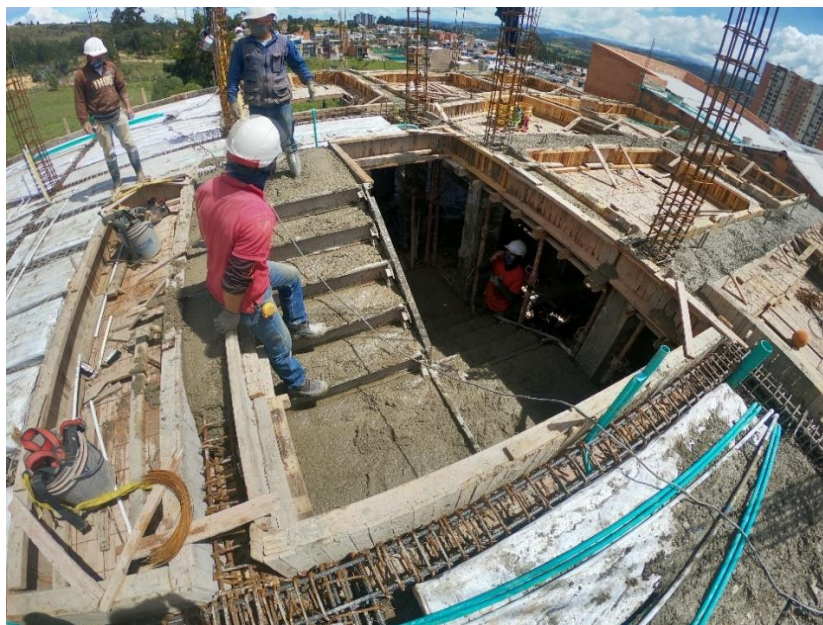
Imagen 34: Fundida de escaleras
