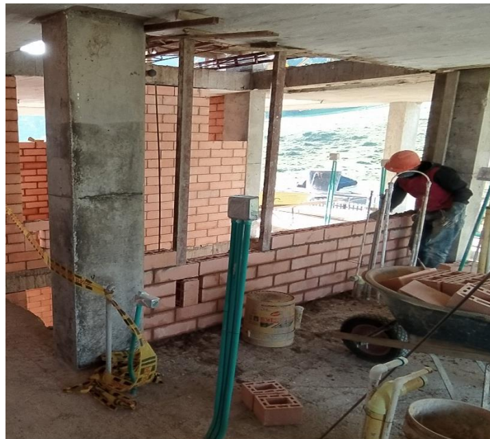
Imagen 16: Alzado de muro y anclaje de dovela
