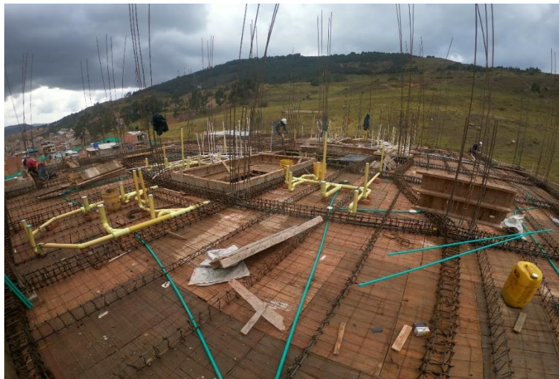
Imagen 22: Armado de Tubería en la placa de entrepiso
