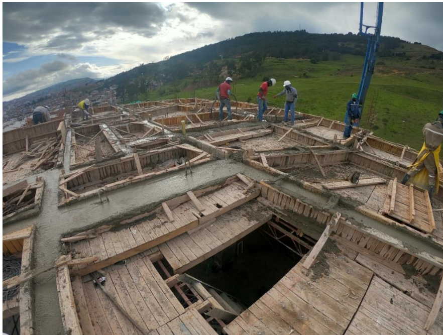
Imagen 35: Fundida de viga canal
