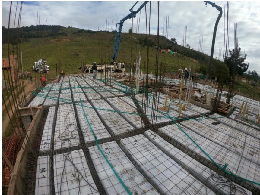
Imagen 32: Aligeramiento de placa de entrepiso
