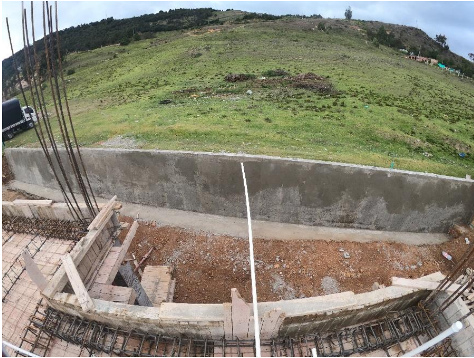
Imagen 43: Muro de contención
