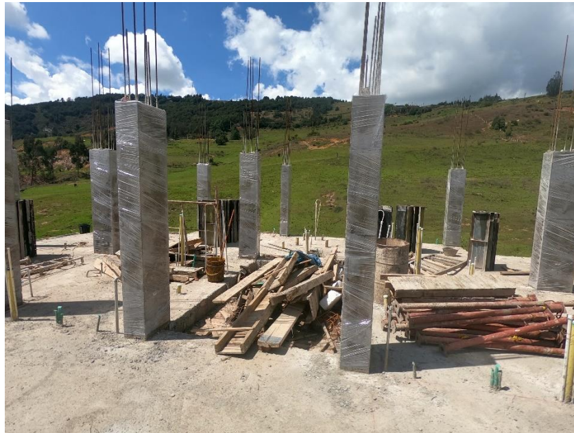
Imagen 28: Desencofrado de columnas
