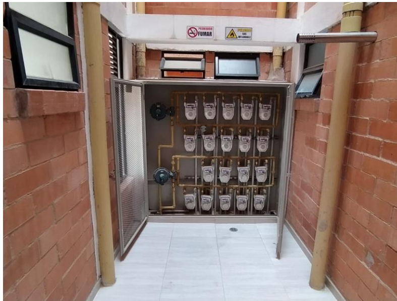
Imagen 23: Centro de medición de gas
