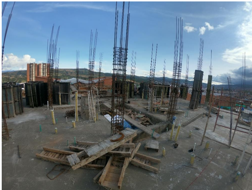
Imagen 26: Acero de columnas
