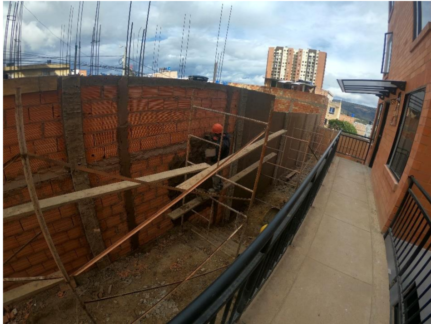
Imagen 41: Alzado de muro y pañetado
