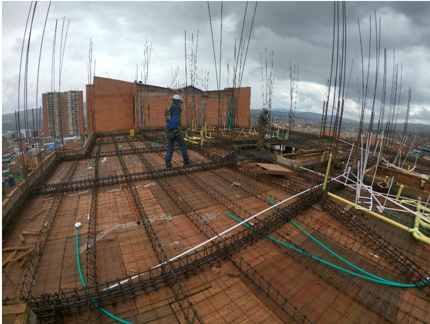
Imagen 29: Acero armado de vigas y viguetas
