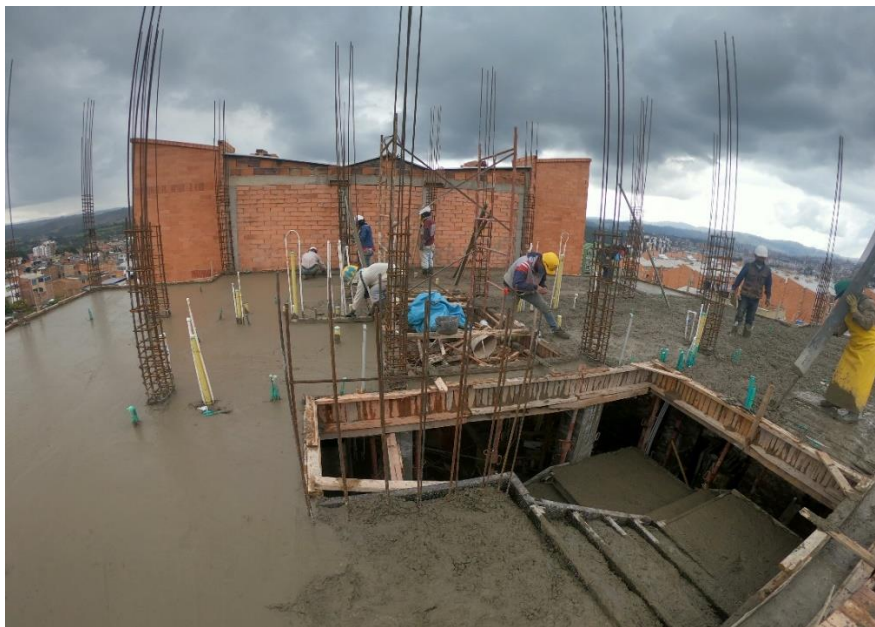
Imagen 33: Fundida de placa de entrepiso y escaleras
