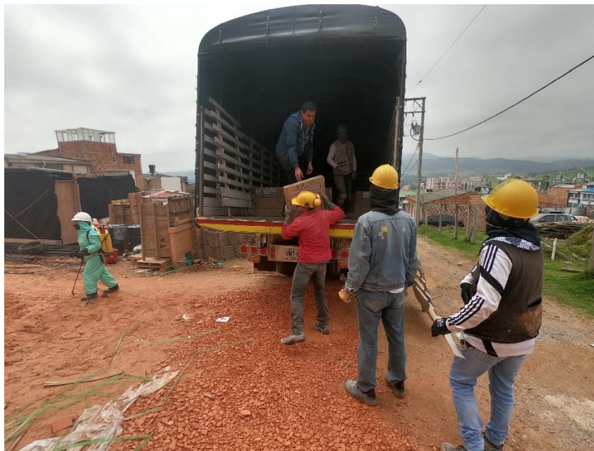
Imagen 45: Recibimiento de pisos para Torre C
