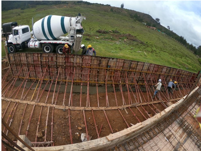
Imagen 42: Fundida de muro de contención
