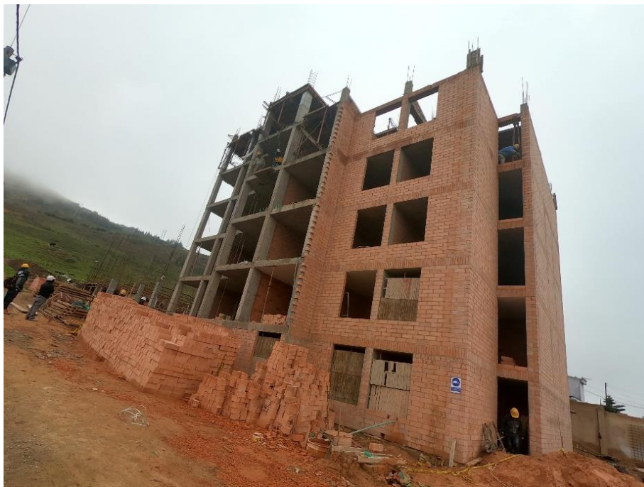
Imagen 13: Avance de Torre C
