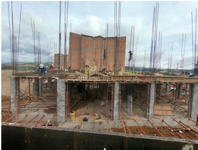
Imagen 31: Estructura de sostenimiento en la fundida de placa de entepiso
