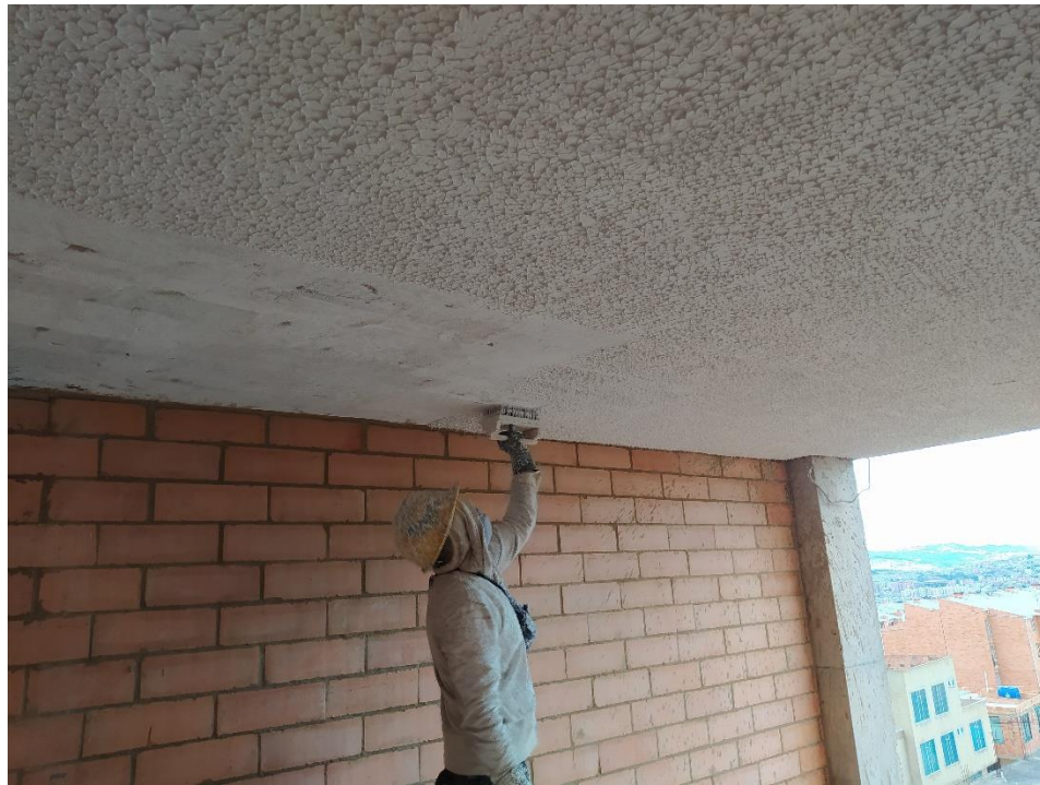
Imagen 20: Aplicación de rústico en el techo
