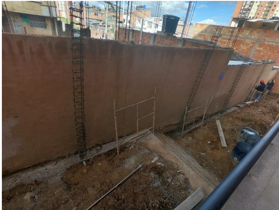
Imagen 40: Refuerzo de columnas
