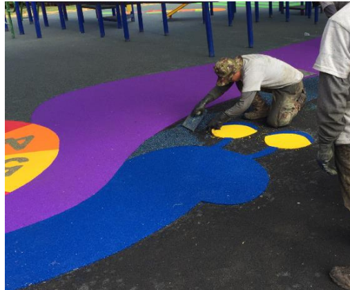
Figura 10.4: Distribución del GCR pigmentado Fuente: [57]
