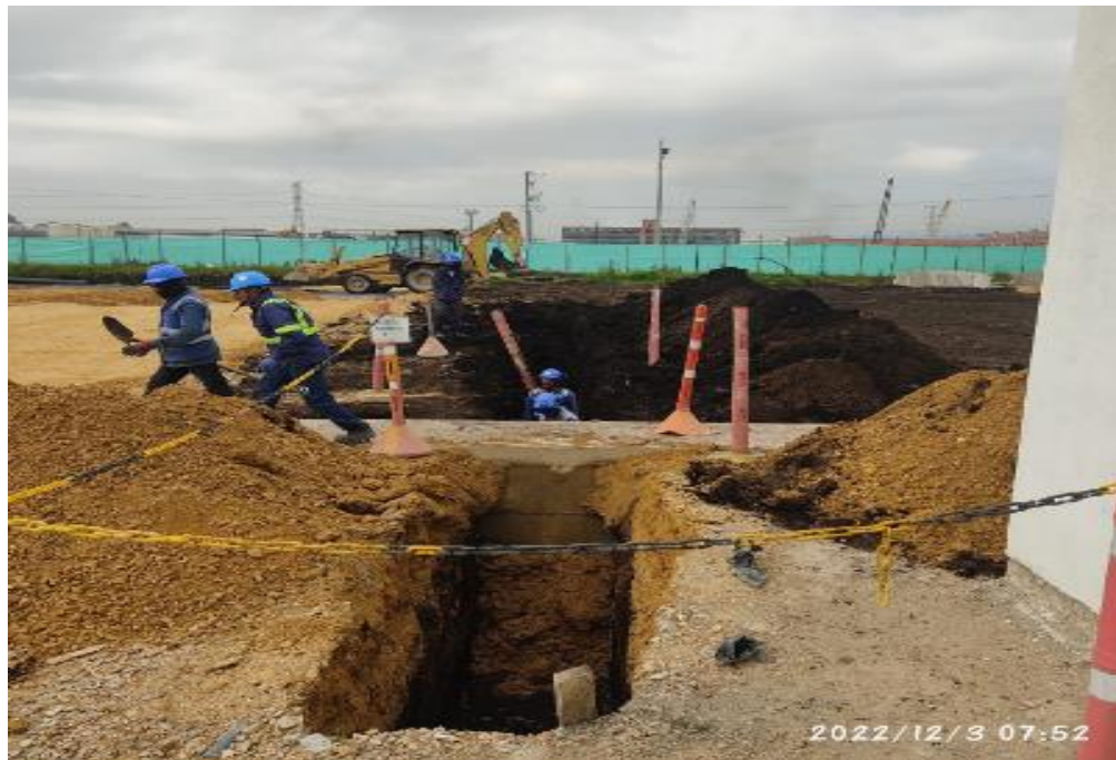
Figura 18 Instalación de tubería Proyecto DHL
