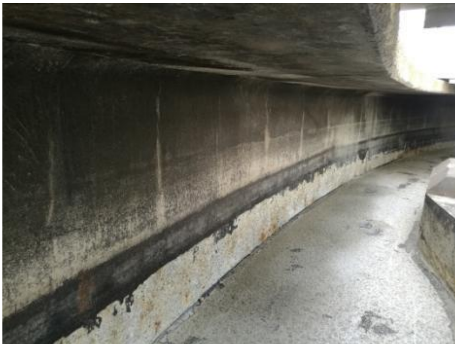
Figura 31. Condición típica de muros y losas en el resto del canal de agua clarificada
