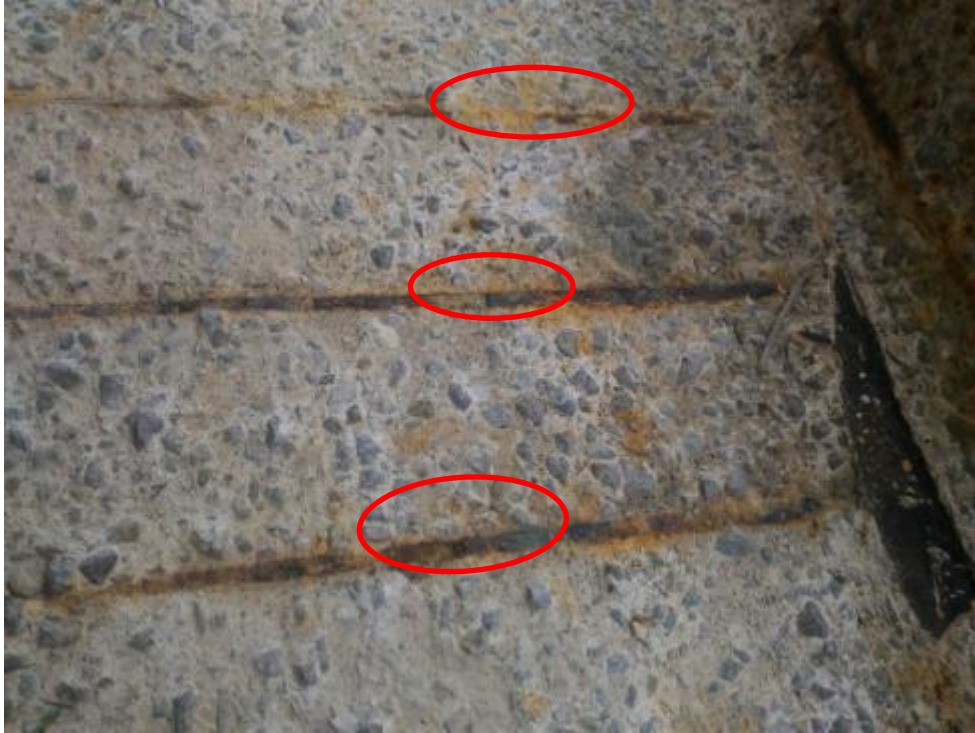
Figura 29. Pérdida de sección transversal en barras del canal de agua clarificada
