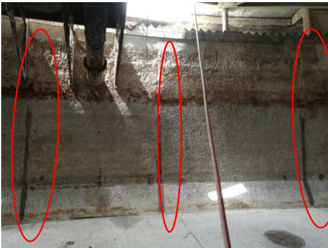
Figura 5. Juntas de construcción verticales en muros
