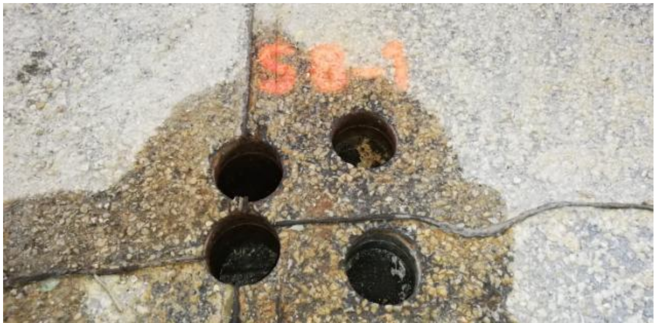
Figura 15. Lámina metálica tratamiento de juntas radiales en losa estructural.
