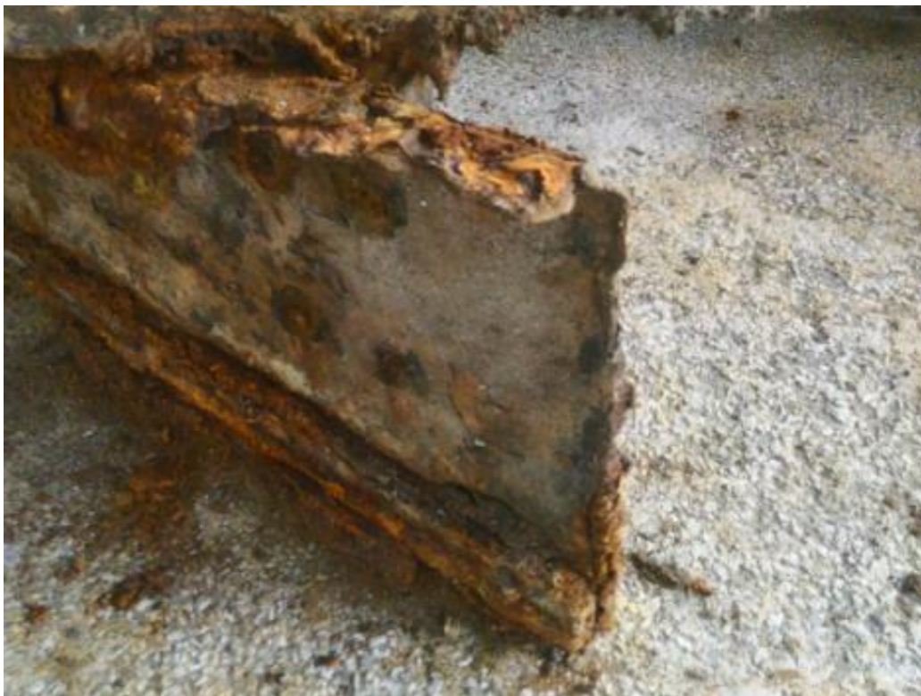
Figura 23. Afectación de aspas del barrelos. Deterioro de neopreno.
