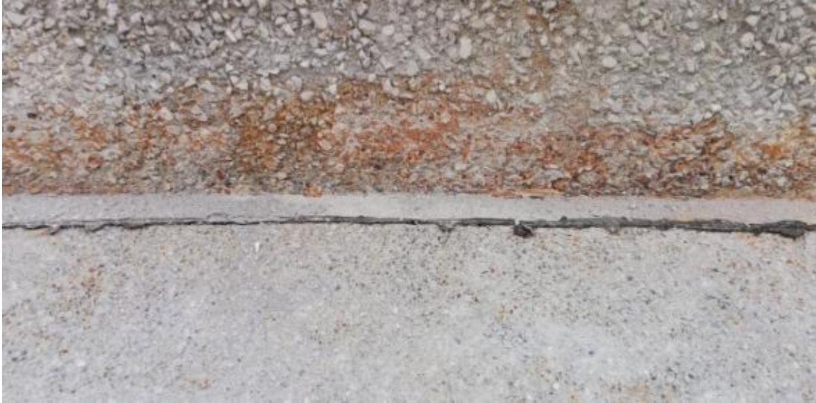
Figura 6. Borde perimetral en unión muro-losa.
