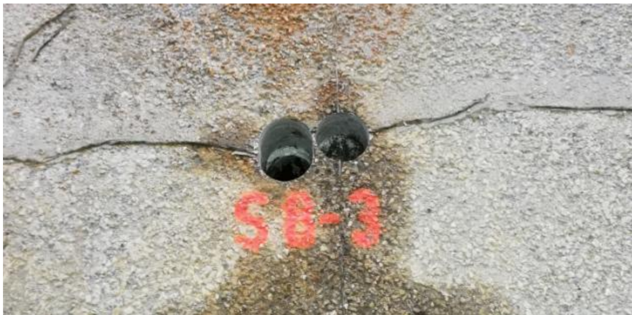
Figura 16. Junta de construcción en sobre-losa.
