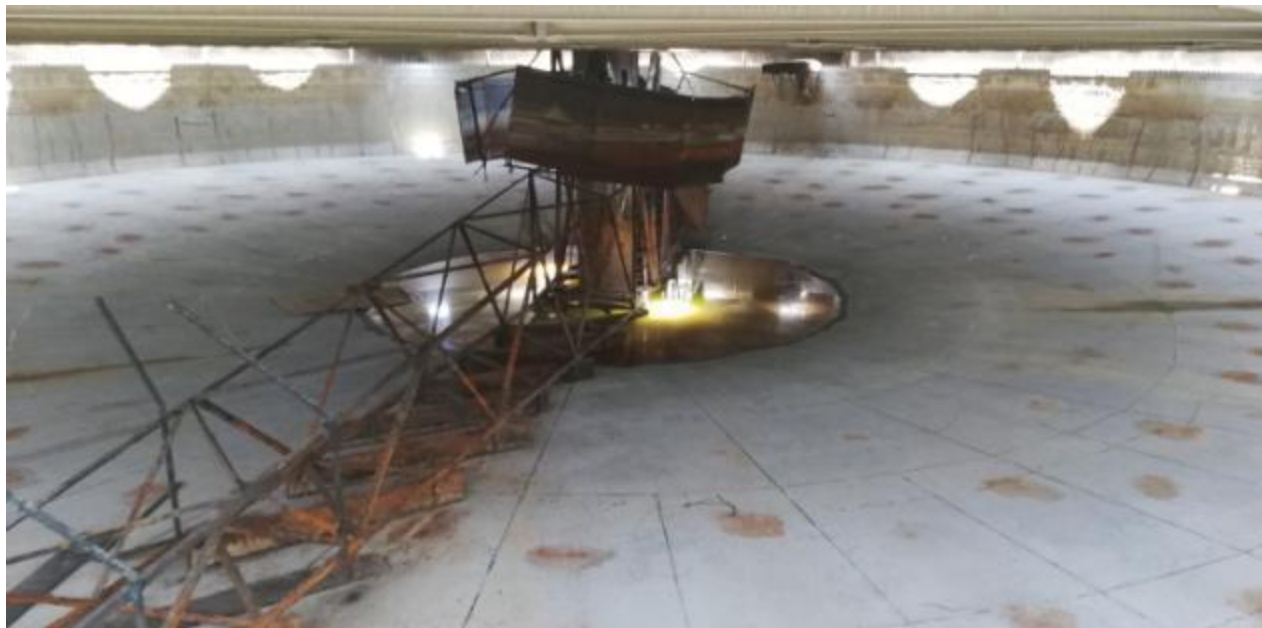
Figura 3. Vista general del interior del Sedimentador 8.
