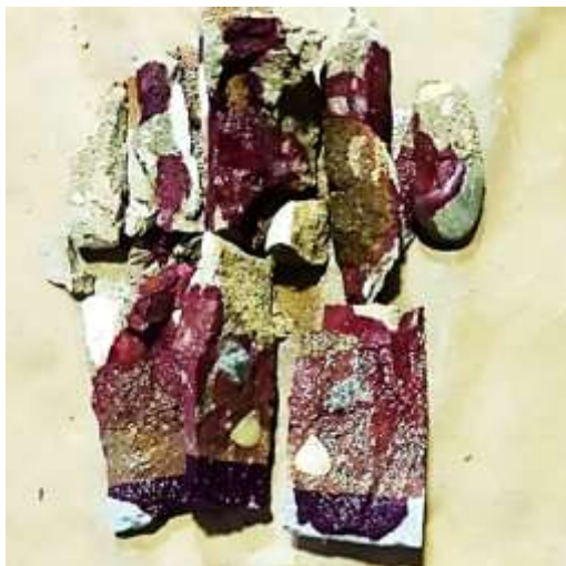
Fotografía 36 Ensayo de Carbonatación tanque sedimentadores
