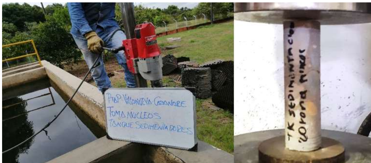
Fotografía 35 Extracción de núcleos tanque sedimentadores
