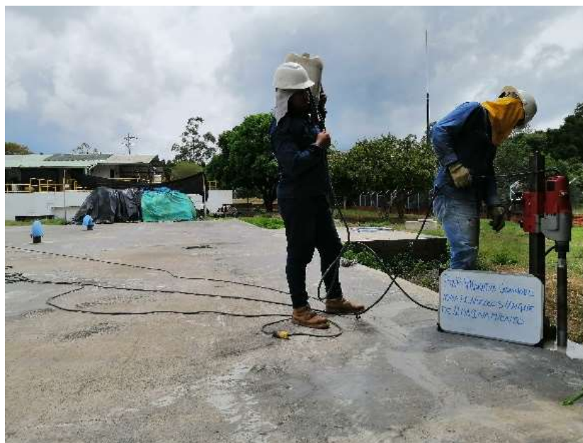
Fotografía 39 Extracción de núcleos tanque almacenamiento
