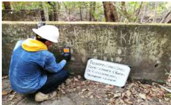
Fotografía 5 Detección de refuerzo Bocatoma Caño Claro
