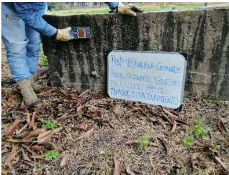
Fotografía 37 Detección de refuerzo tanque almacenamiento
