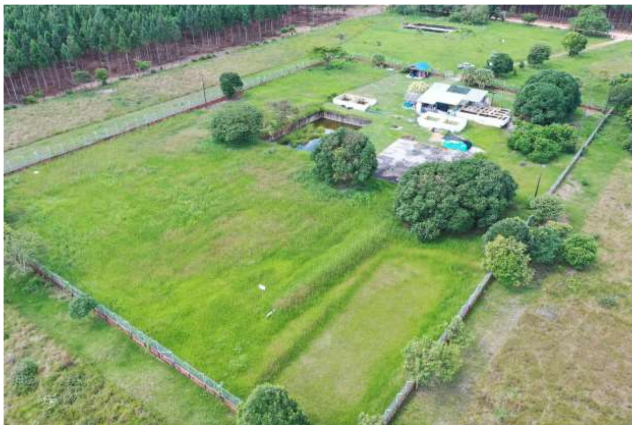
Fotografía 1 Vista general aérea de la PTAP
