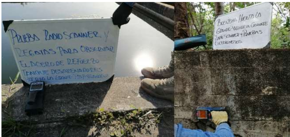
Fotografía 12 Detección de refuerzo bocatoma y desarenador Huerta La Grande
