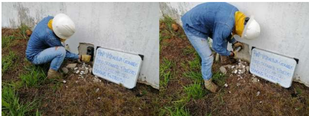
Fotografía 20 Toma de lectura de esclerómetro No. 1 y 2
