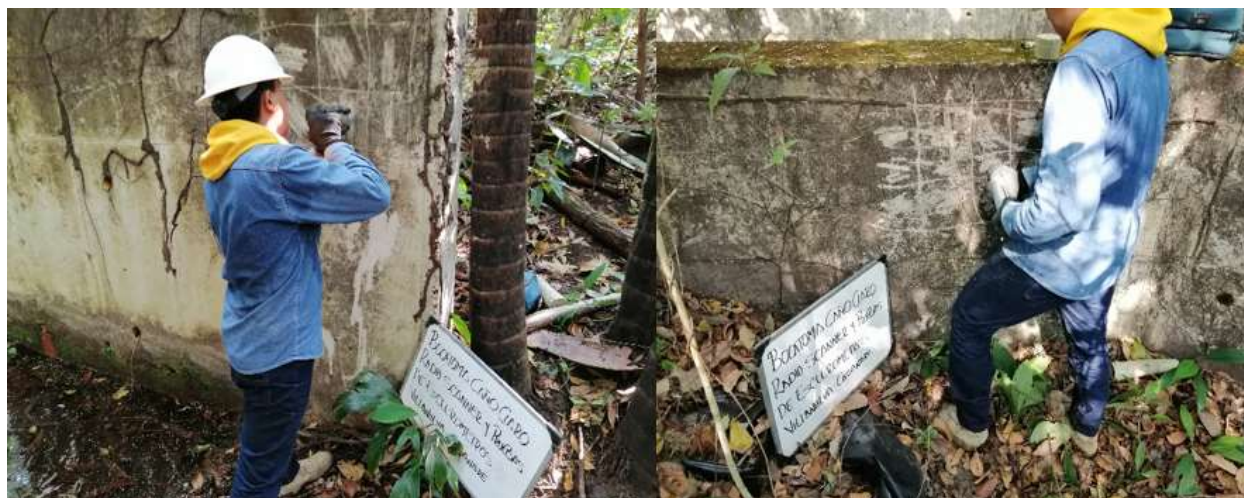
Fotografía 7 Toma de lectura esclerómetro muro externo 1 y muro interno 1.
