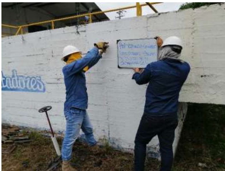
Fotografía 34 Toma de lectura de esclerómetro tanque sedimentadores
