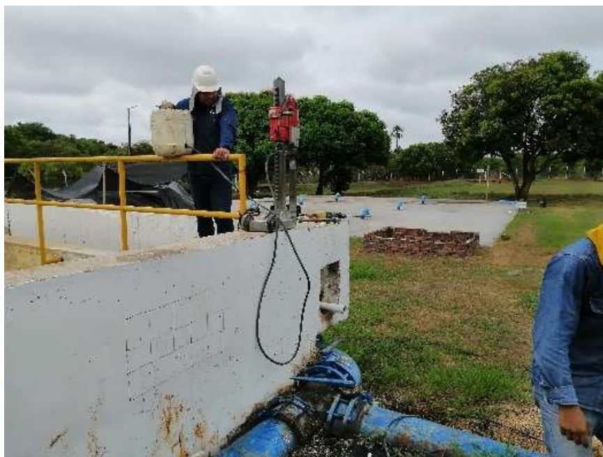
Fotografía 25 Toma de lectura de esclerómetro No. 1 tanque unidad de filtros
