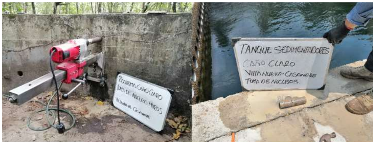
Fotografía 8 Extracción de núcleos Bocatoma y Sedimentador Caño Claro
