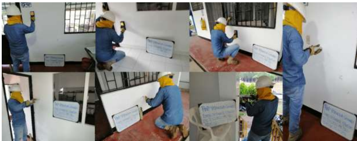
Fotografía 41 Toma de lectura de esclerómetro zona administrativa
