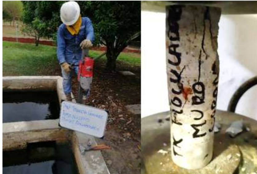
Fotografía 31 Extracción de núcleos tanque floculadores
