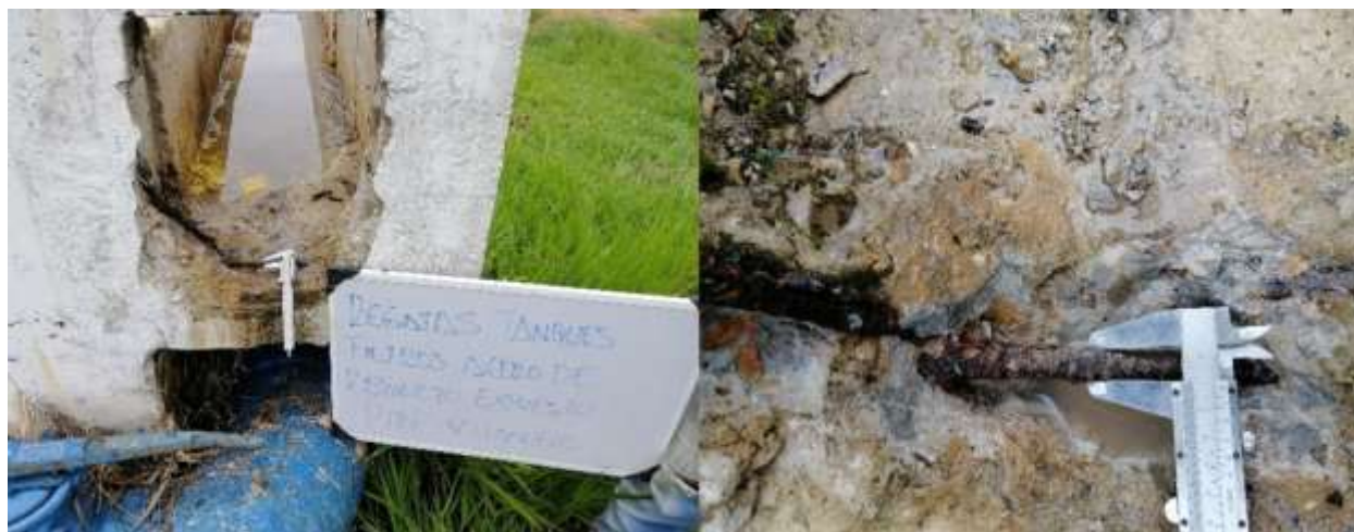
Fotografía 28 Regata en elemento de concreto tanque unidad de filtros
