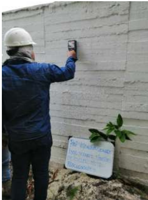
Fotografía 29 Detección de refuerzo tanque floculadores
