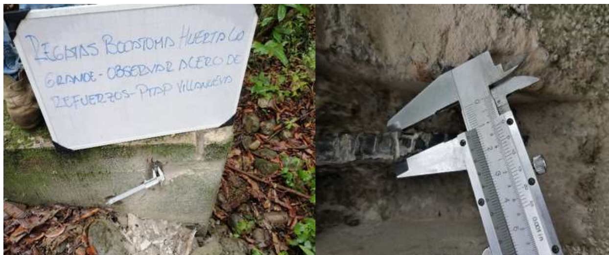
Fotografía 17 Regata en elemento de concreto, bocatoma Huerta La grande
