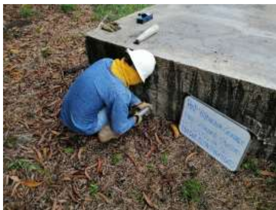
Fotografía 38 Toma de lectura de esclerómetro tanque almacenamiento
