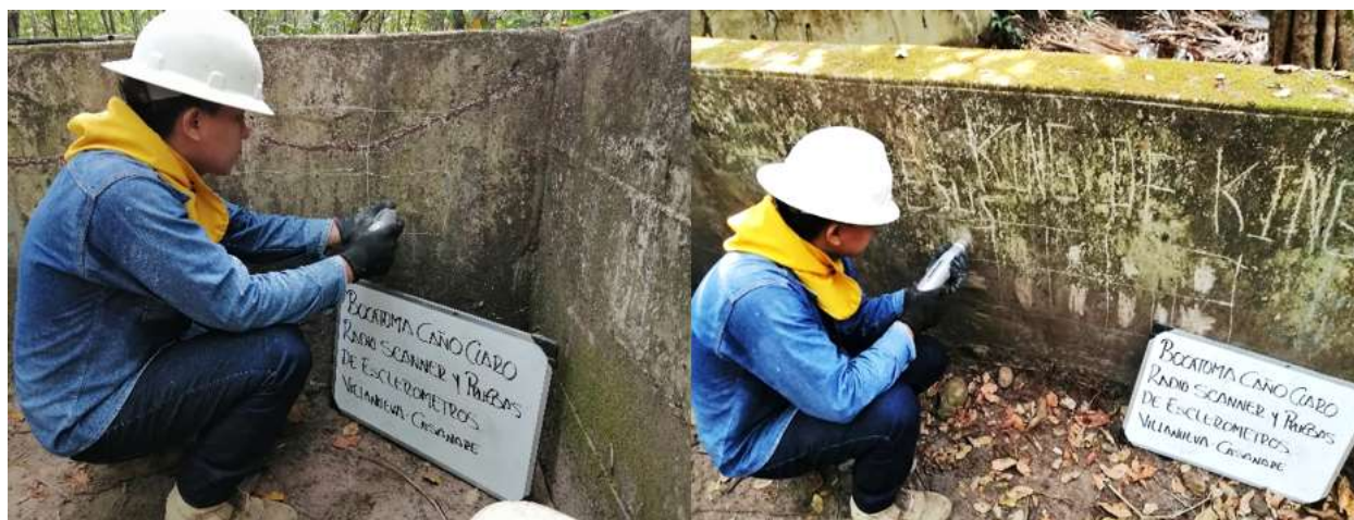
Fotografía 6 Toma de lectura de esclerómetro muro interno 1 y 2.
