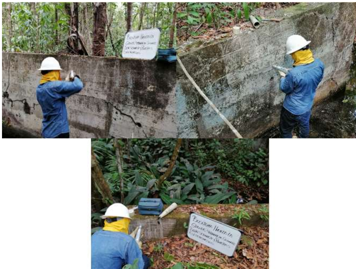
Fotografía 13 Toma de lectura de esclerómetro No. 1, 2 y 3.
