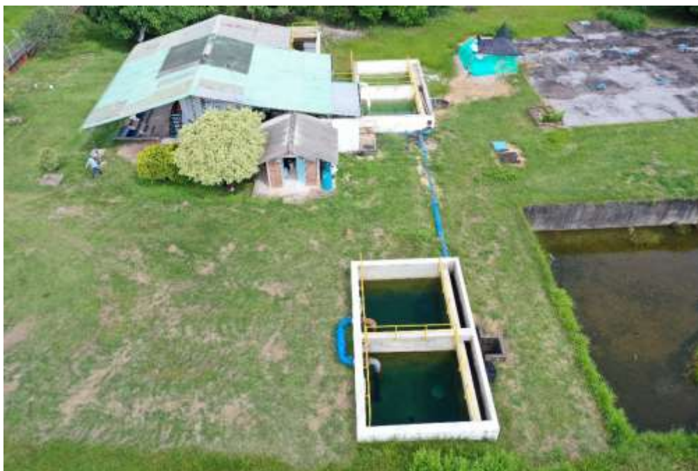
Fotografía 2 Vista aérea de tanques y edificación para operación.
