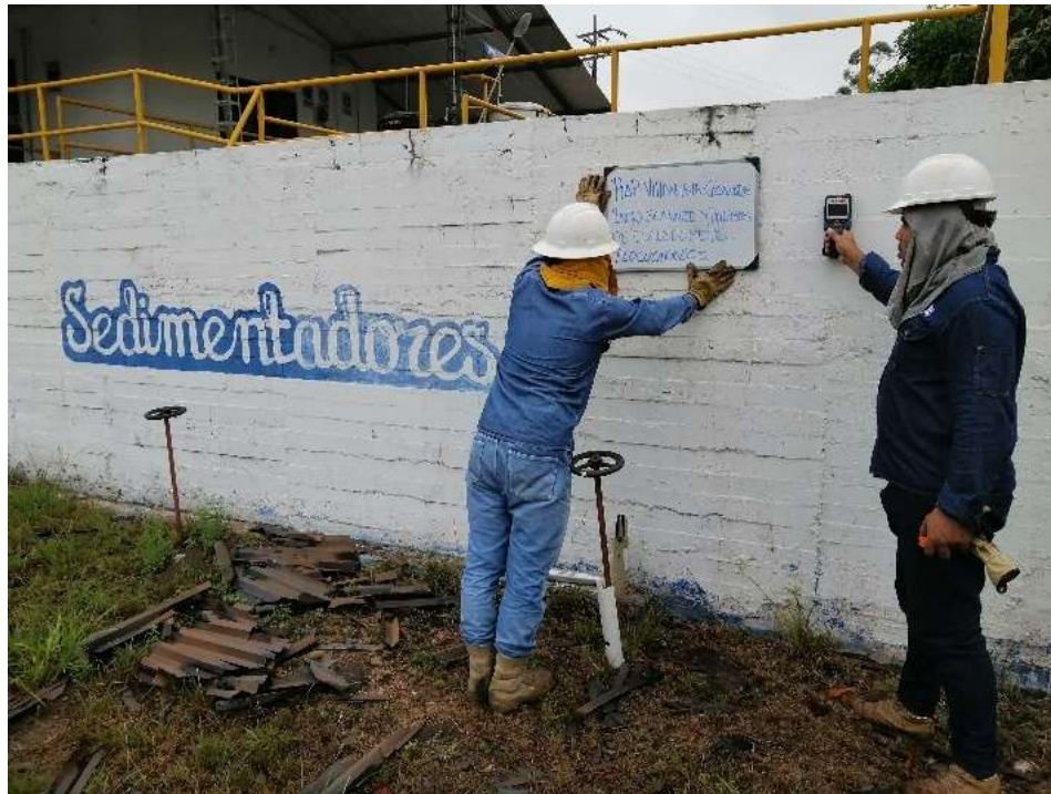
Fotografía 33 Detección de refuerzo tanque sedimentadores
