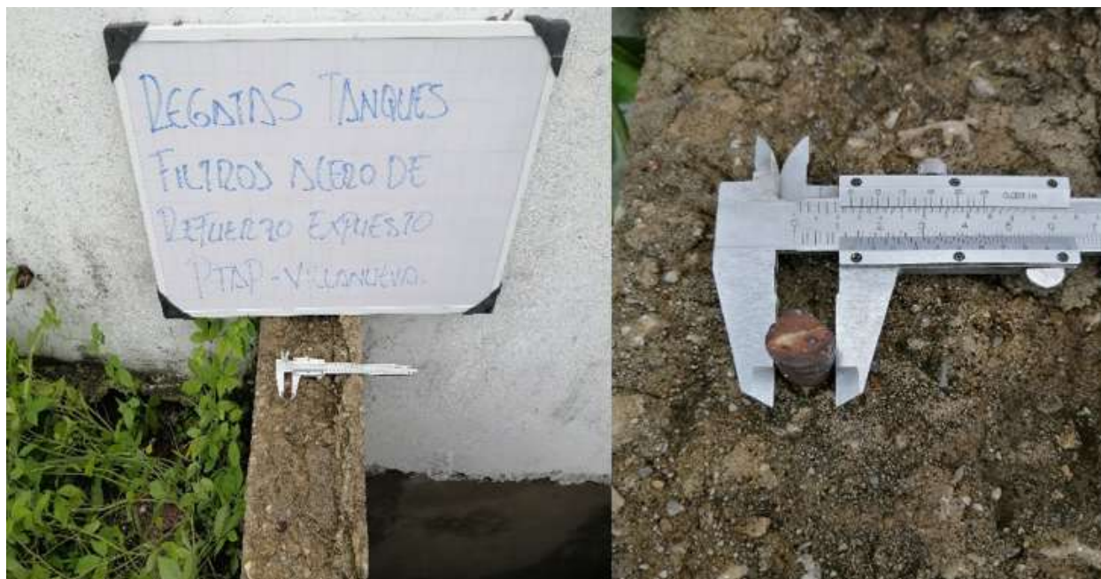
Fotografía 23 Regata en elemento de concreto tanque de filtros
