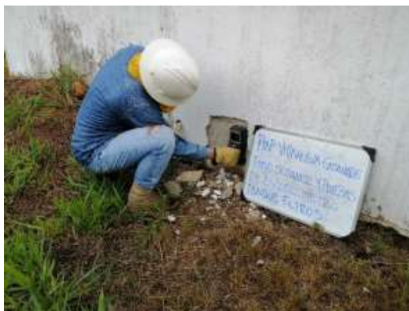
Fotografía 19 Detección de refuerzo tanque de filtros
