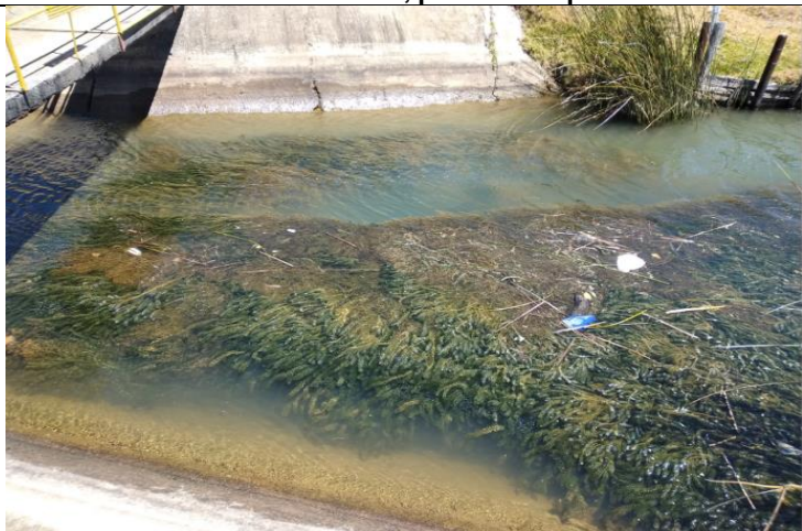
Foto 3. Estado del punto de Captación.
