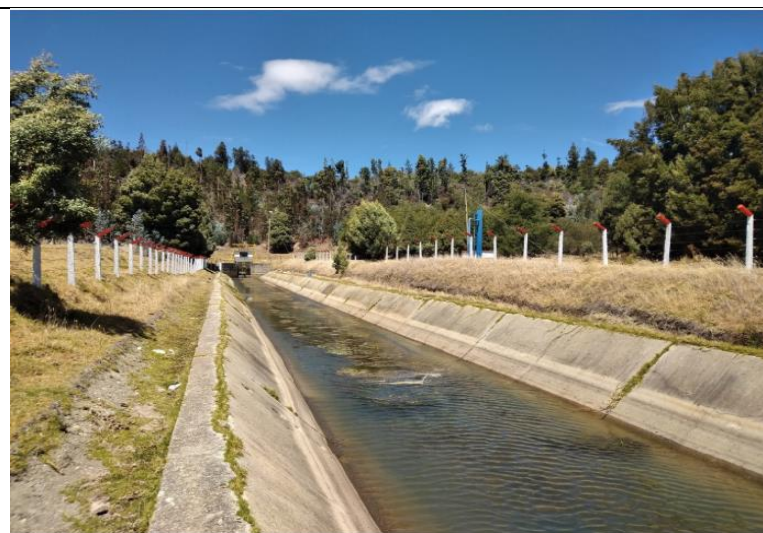
Foto 1. Canal abierto, punto de captación.
