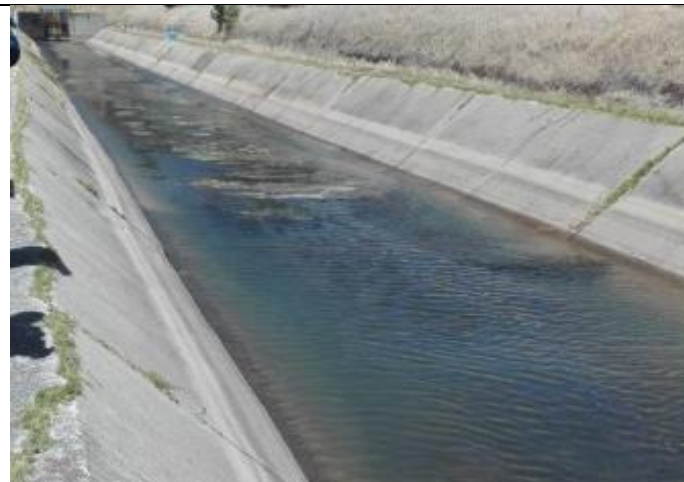
Foto 4. Estado del Canal Abierto.
