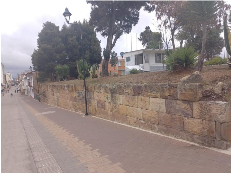
Figura 3 Muro de bloque del bosque (Muro San Laureano)
