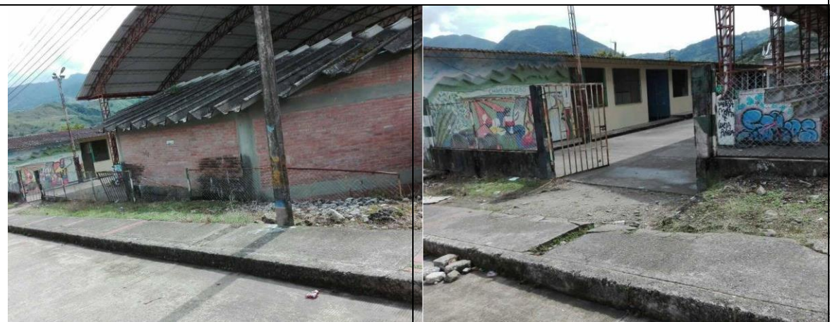
Fotografía 17. Diagnóstico del estado actual del polideportivo municipal.
