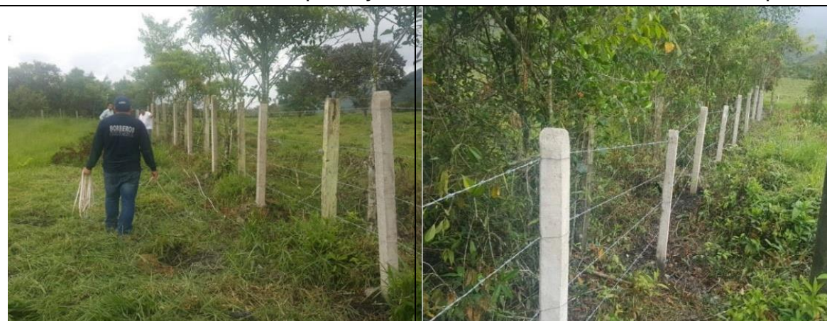
Fotografía 10. Instalación de postes en concreto de 2,0 m de altura con una distancia de 2,5 m entre cada poste y la instalación de 4 hilos de alambre de púas.
