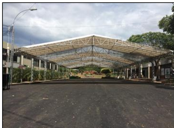
Figura 10 Montaje techos CDJ
