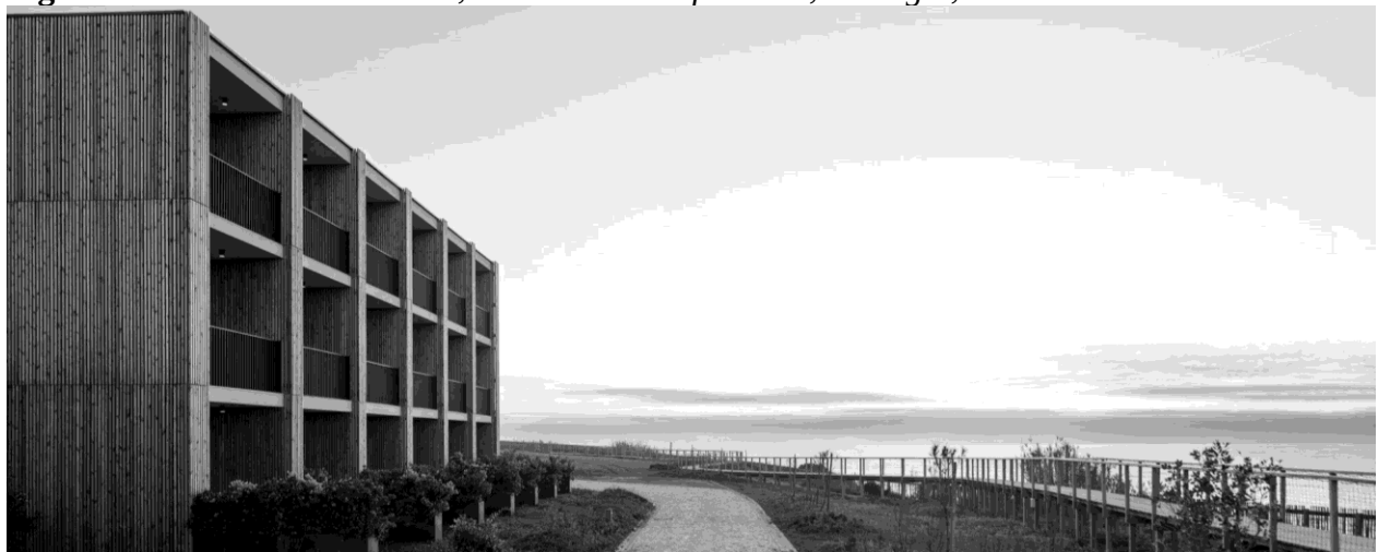
Figura 9. Hotel Aethos Ericeira, Pedra Silva Arquitectos, Portugal, 2022.
