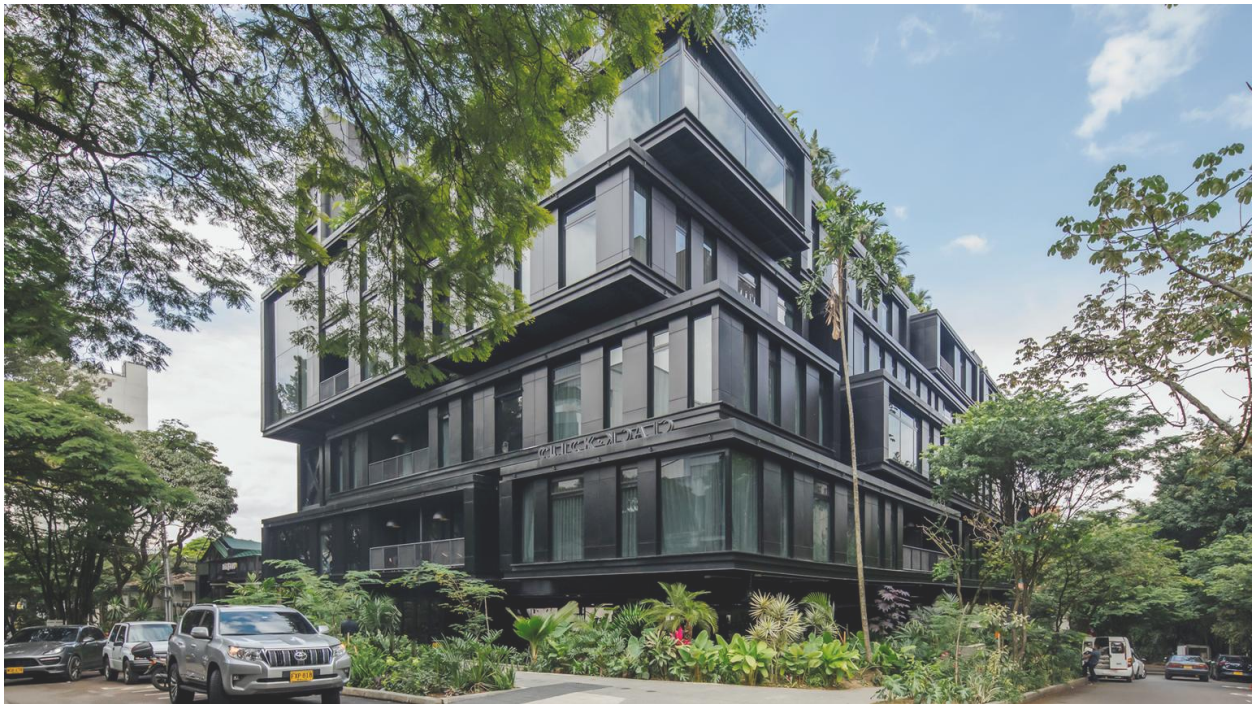
Fotografía externa a nivel de observador de Fachada Esquinera.
