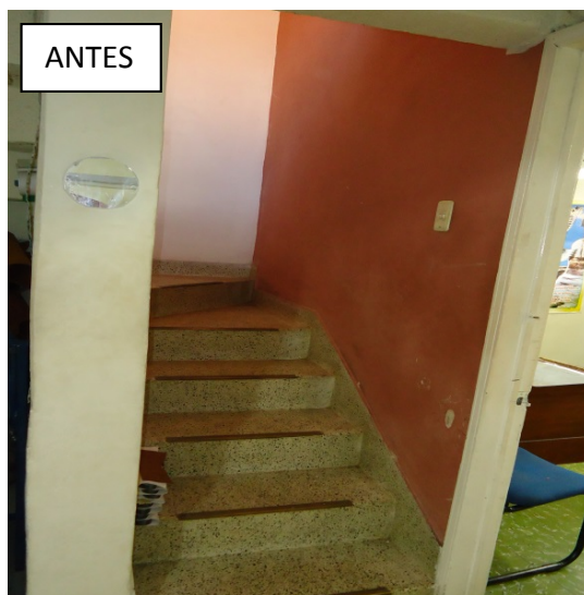
Figura 18. Área de escaleras
