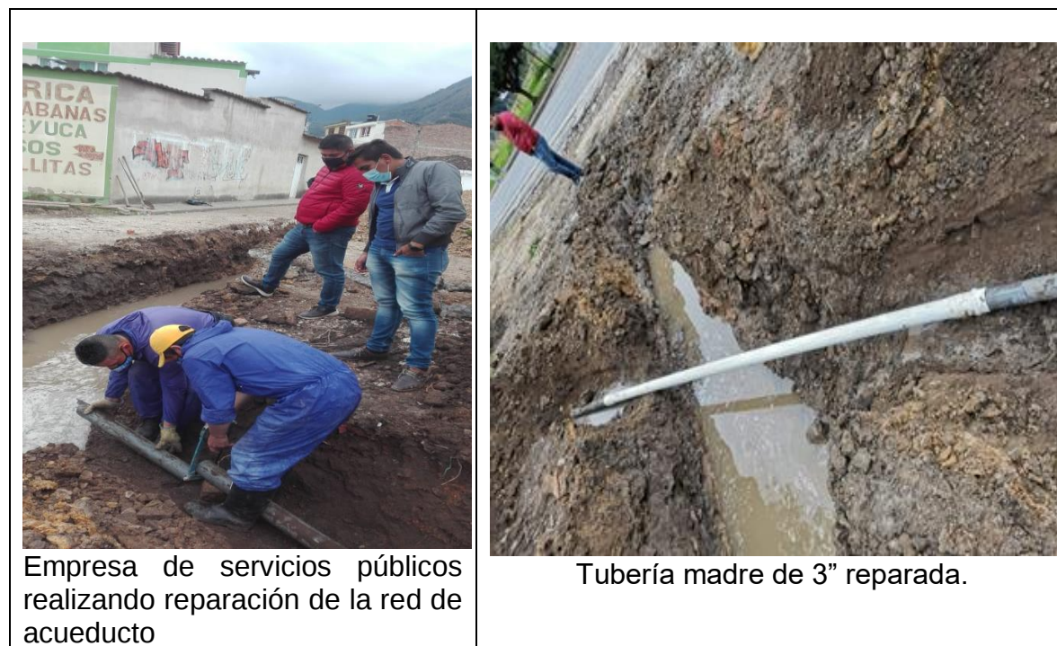
Ilustración 14. Registro fotográfico reparación de red madre acueducto
