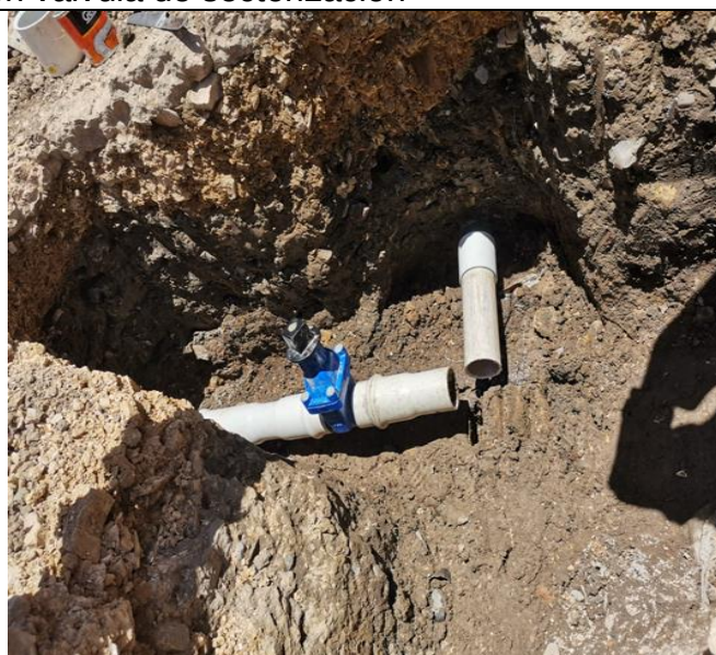
Instalación válvula de sectorización
