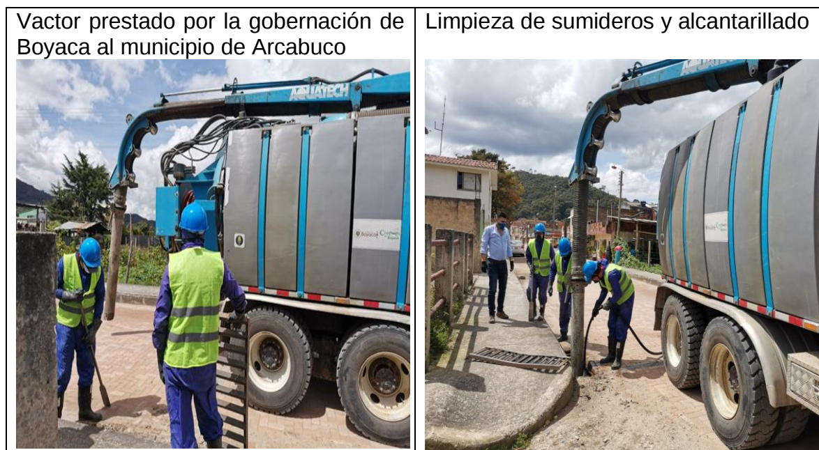
Ilustración 17. Registro fotográfico Limpieza alcantarillado con el Vactor
