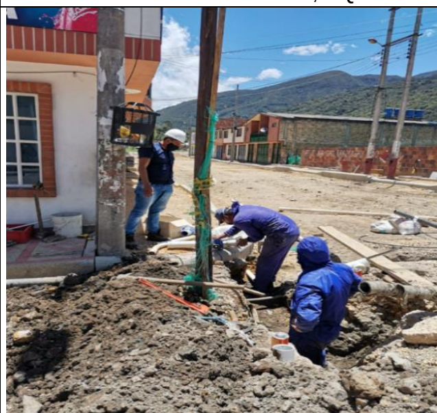
Verificación Instalación válvula de sectorización
