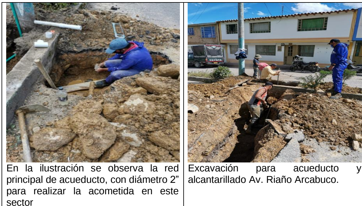
Ilustración 7. Verificación acometida acueducto
