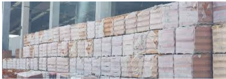
Ilustración 14 Almacenamiento de ladrillos.
