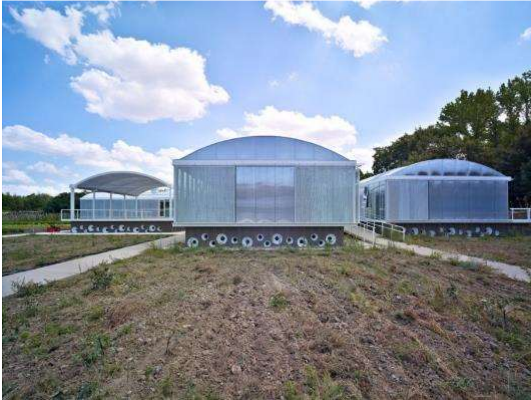
Figura 19. Fachada posterior Escuela Granja.
