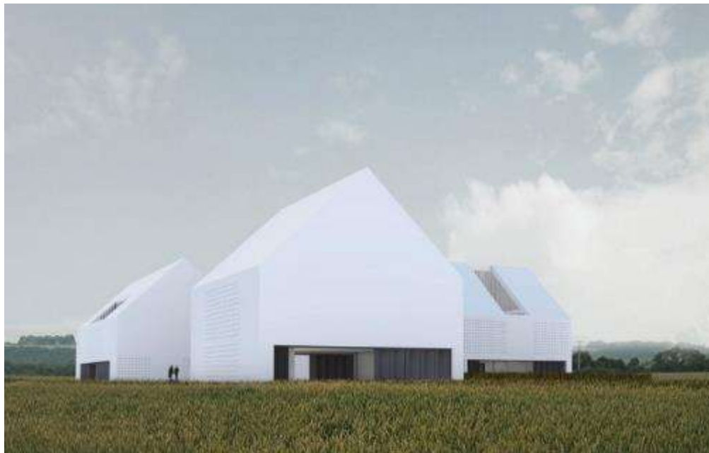
Figura 16. Foto fachada Escuela Granja, Motor de Identidad Rural.
