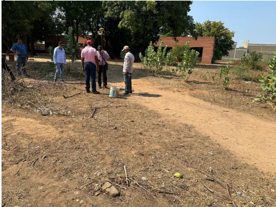
Figura 10. Acompañamiento a comisión topográfica de la alcaldía. Proyecto construcción de nueva sede defensoría del pueblo
