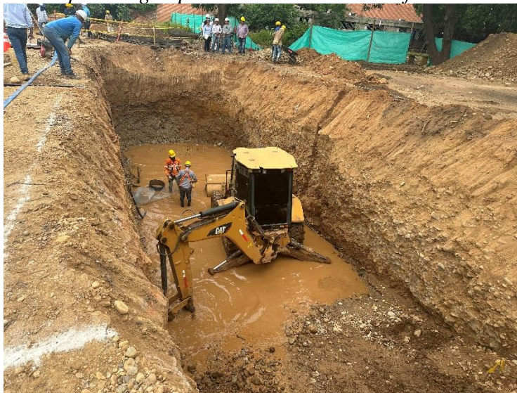
Figura 14. Excavación tanque de agua potable. Construcción defensoría del pueblo
