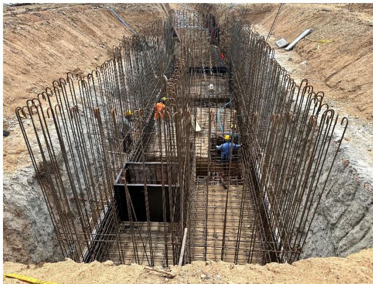
Figura 15. Armado del acero de refuerzo, tanque agua potable. Construcción defensoría del pueblo
