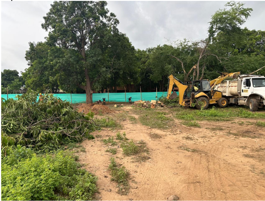
Figura 11. Visita inicio de obras preliminares construcción nueva sede de la defensoría del pueblo, Valledupar
