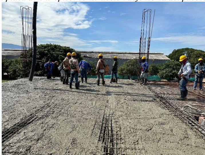
Figura 17. Fundición placa de entrepiso. construcción defensoría del pueblo
