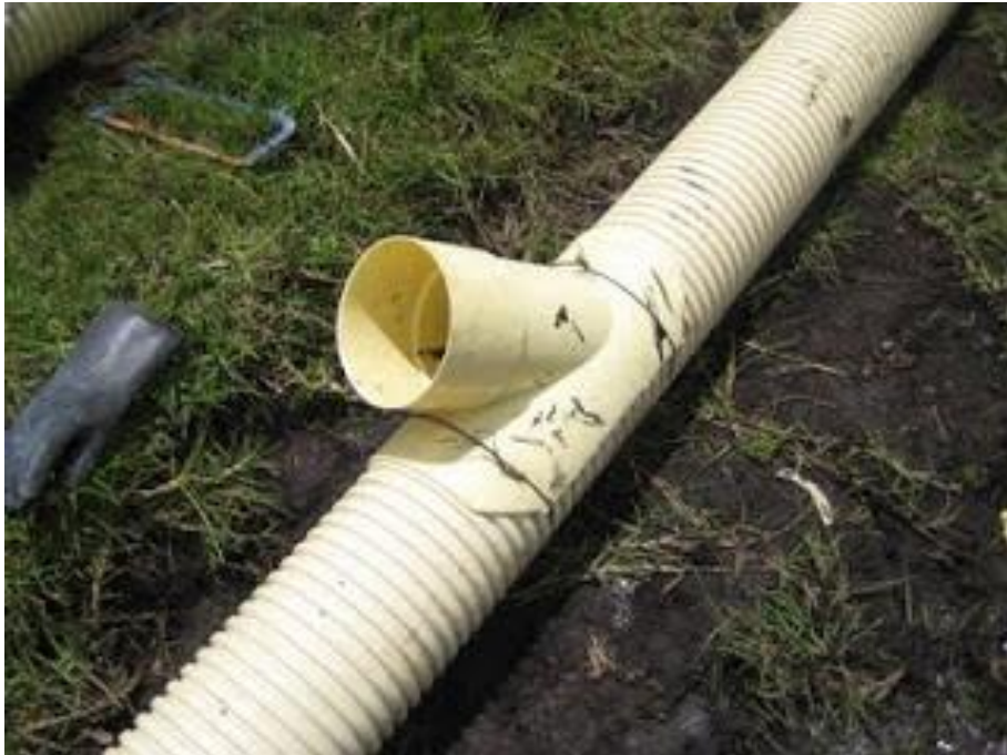
Ilustración 13, imagen de conexión con silla yee tubería Novafort
