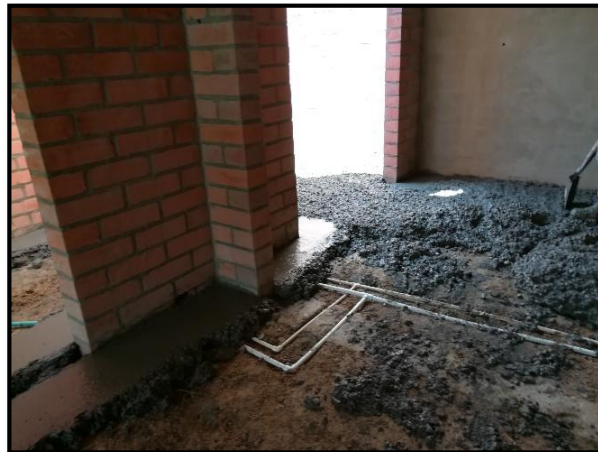
Fotografía 13. Fundición de piso.
