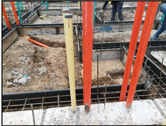
Fotografía 2. Fundición de viga de cimentación.
