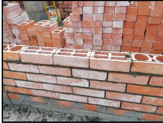
Fotografía 5. Elaboración de muros.
