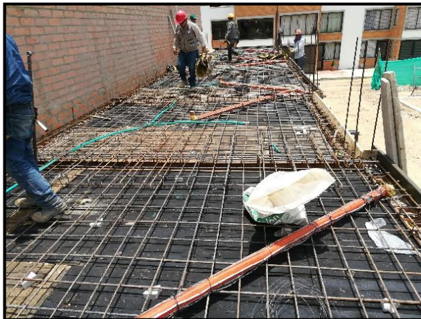
Fotografía 9. Placa de entrepiso.
