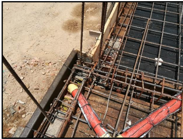
Fotografía 8. Placa de entrepiso.
