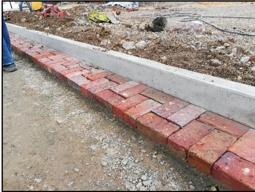
Fotografía 18. Colocación de adoquines.
