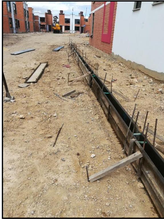
Fotografía 16. Fundición de sardineles.
