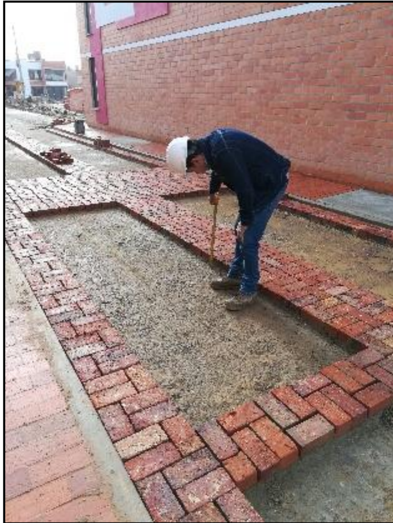
Fotografía 21. Inspección de vía.
