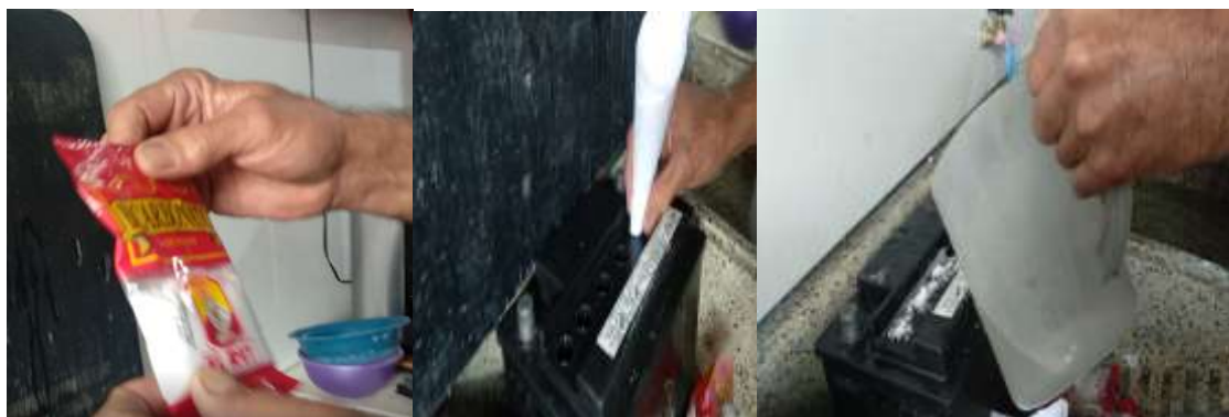
Fotografía 7. Aplicación del bicarbonato de sodio y emisión de gases \text{CO}_2
