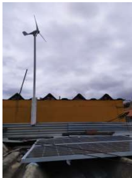
Fotografía 16. Sistema híbrido de generación de energía implementado Fuente: Autores
