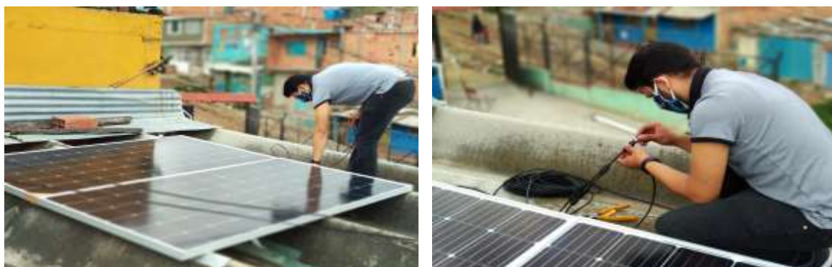
Fotografía 12. Instalación de los paneles solares Fuente: Autores
