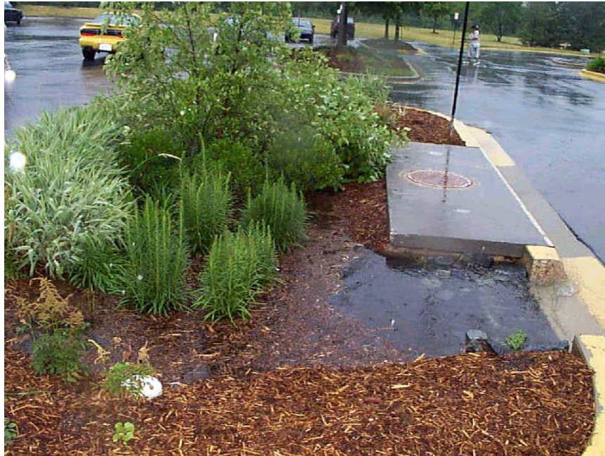
Ilustración 5 Zona de bio-retención
