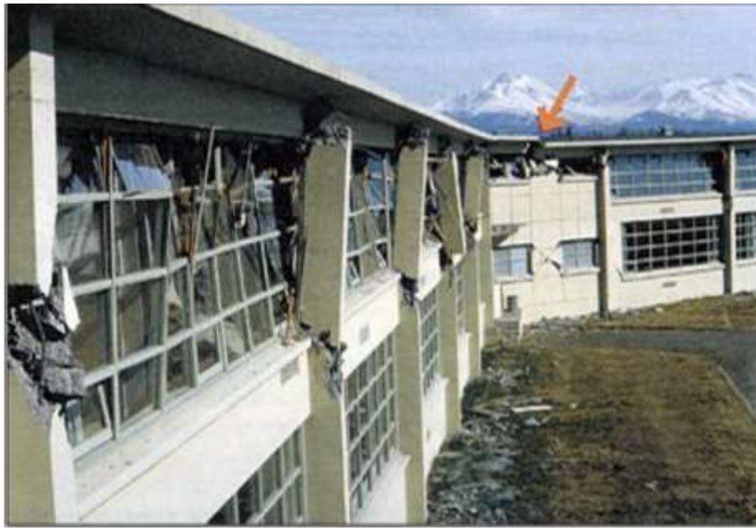
Figura 1. Escuela secundaria en Alaska posterior al sismo, 1964.
