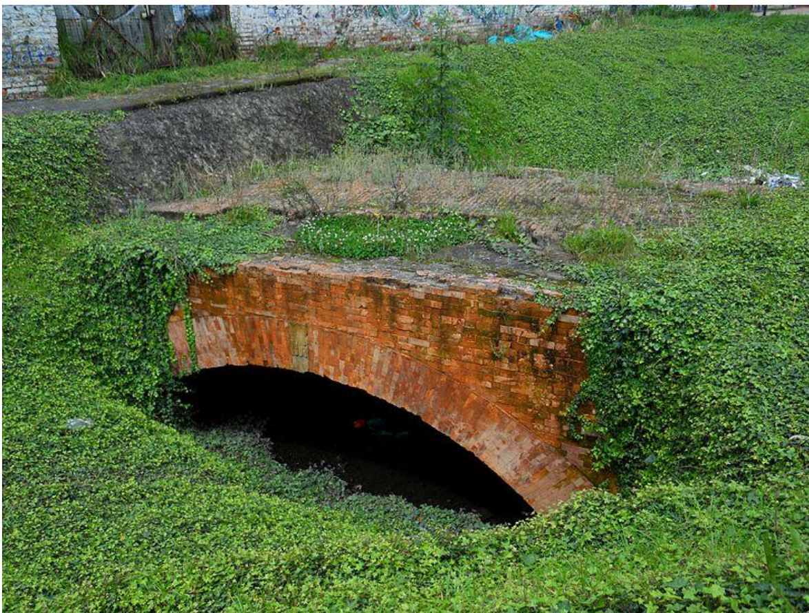
Puente sector Quinta de Bolívar. Foto SDA, 2018.
