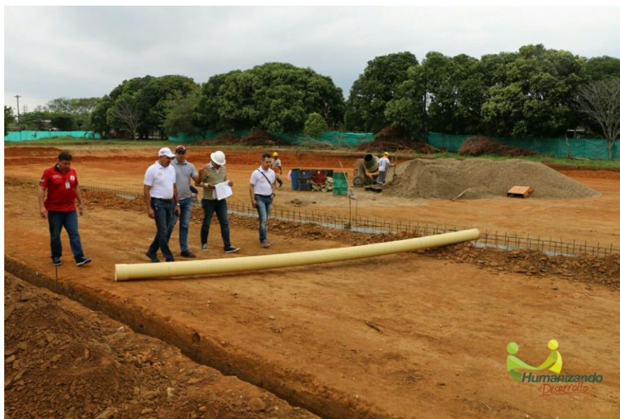
Figura 5. Inicio obras pista de patinaje, Tame
