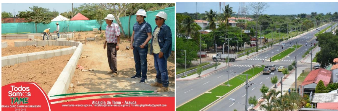
Figura 6. Inicio de obras de espacio público, andenes y vías urbanas
