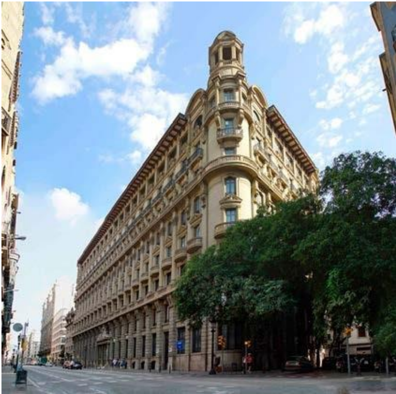
Figura 10. Edificio BSH a intervenir. Fuente: Archmedium
