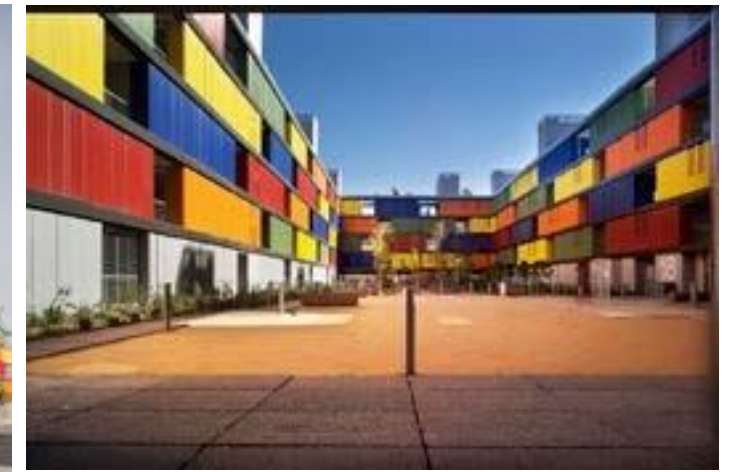
Figura 15. Patio central 82 viviendas de Carabanchel. Fuente: archdaily.co
