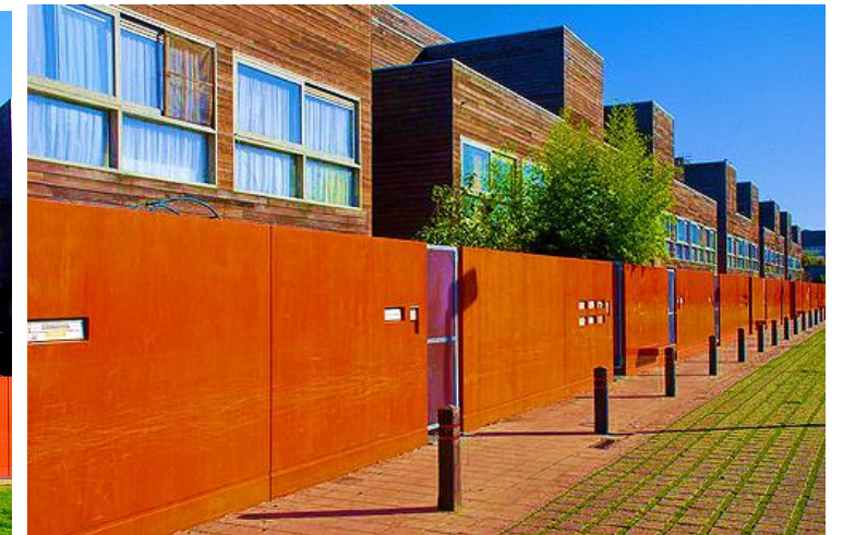
Figura 21. Fachada Hollainhof. Fuente: habitatgecollectiu
