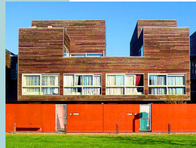
Figura 20. Fachada Hollainhof. Fuente: habitatgecollectiu
