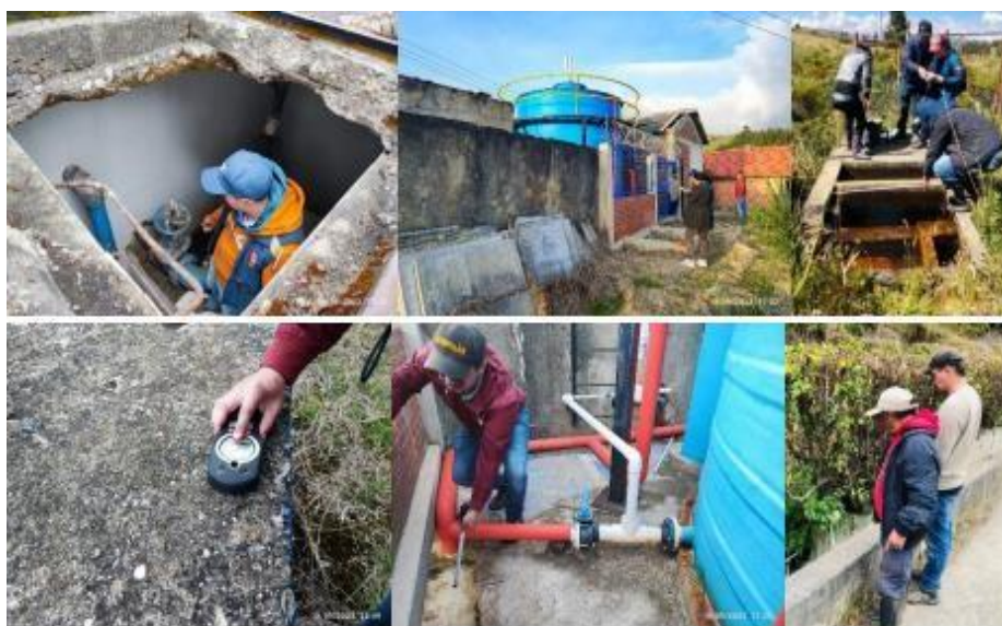
Imagen 11. Evaluación Infraestructura PTAP.
