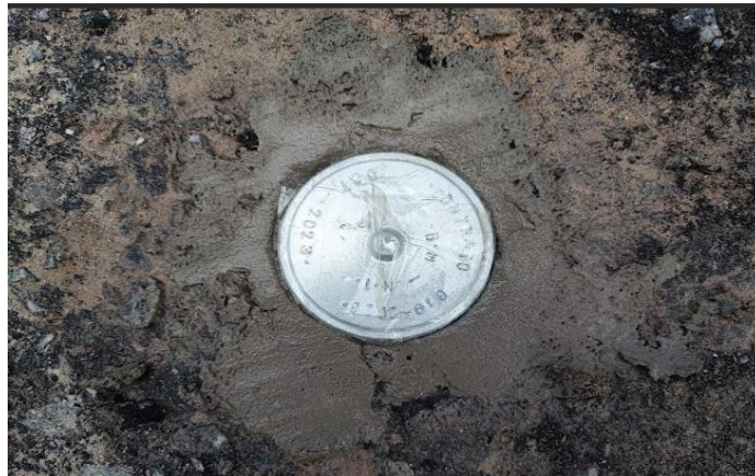
Imagen 4. Instalación de BMS
