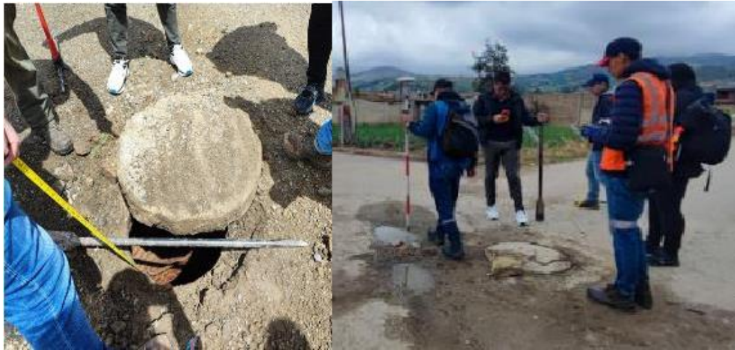
Imagen 17. Inspección de pozos existentes.
