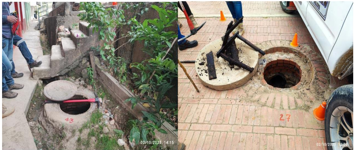
Imagen 6. Inspección de Pozos Existentes
