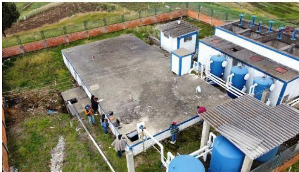
Imagen 9. Levantamiento Topográfico de la PTAP del sector Santuario.
