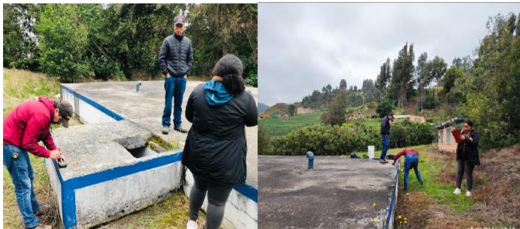
Imagen 8. Levantamiento Topográfico del Tanque de almacenamiento sector Vivero
