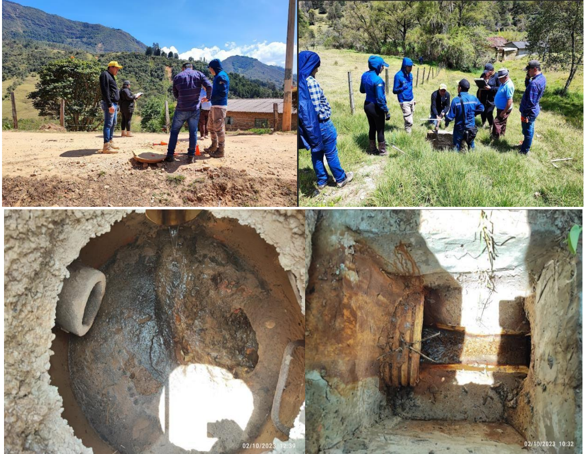
Imagen 5. Evaluación de alcantarillado - Pozos de Inspección
