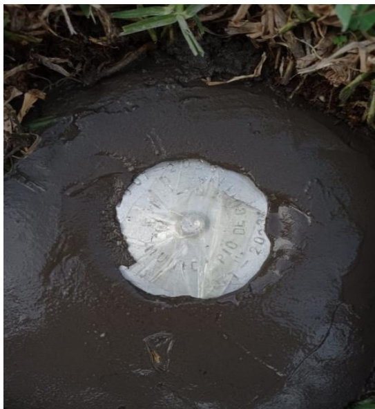
Imagen 24. Instalación de BMS, sector Cuitiva.
