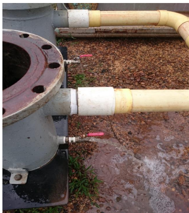
Figura 10. Válvulas de monitoreo. Por López, 2019.
