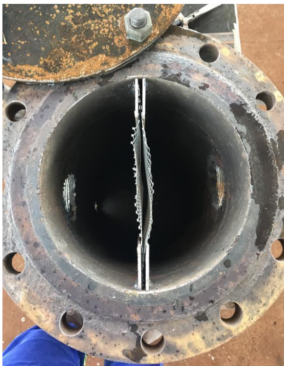
Figura 7. Malla metálica instalada Filtro Bypass RSS-0112. Por López, 2019.
