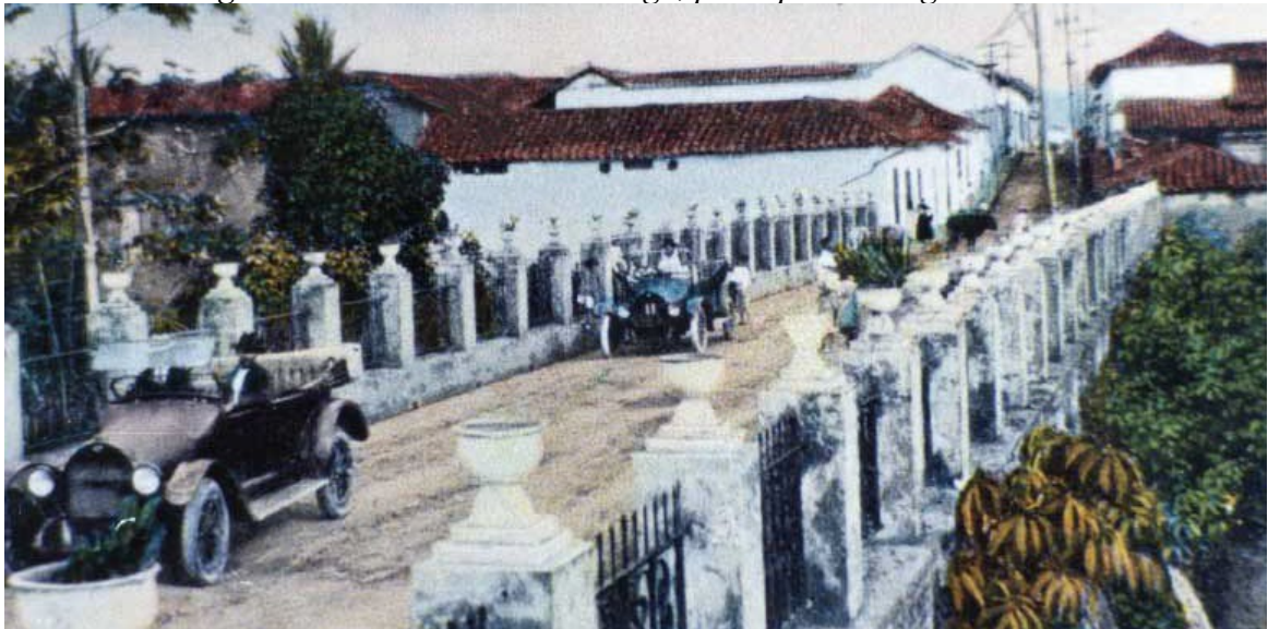
Figura 8. Puente de ingreso al centro de Bucaramanga, principios del siglo XX
