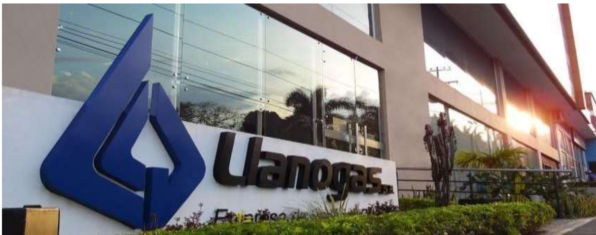
Figura 1. Sede principal Llanogas S.A E.S.P 7 de agosto
