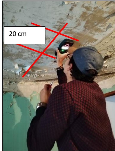
Ilustración 17. Localización del acero en la parte inferior de la losa
