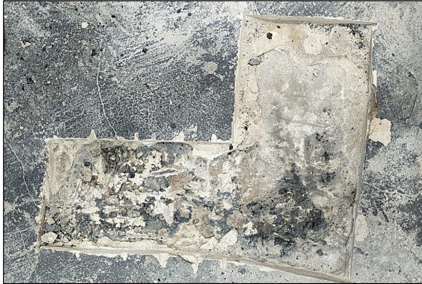
Ilustración 20. Remoción del mortero de nivelación. Fuente propia
