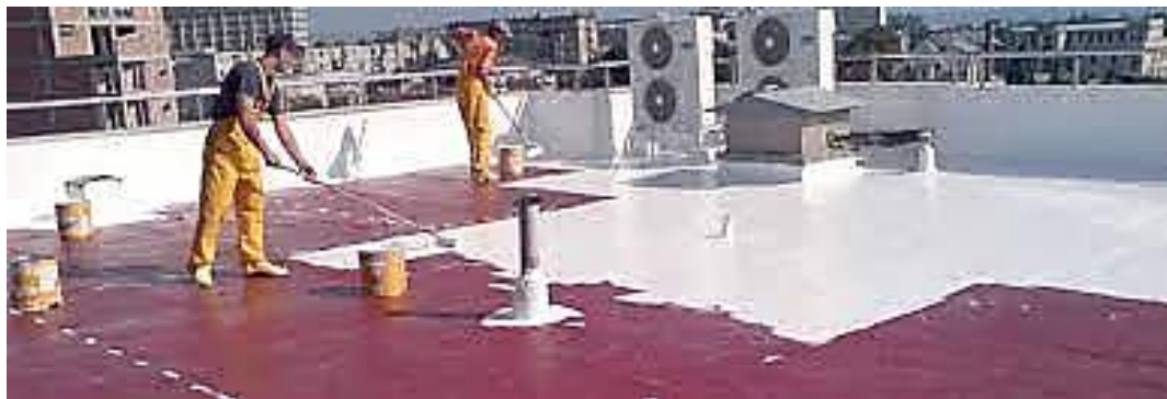
Ilustración 36. Aplicación de membrana líquida en cubierta.
