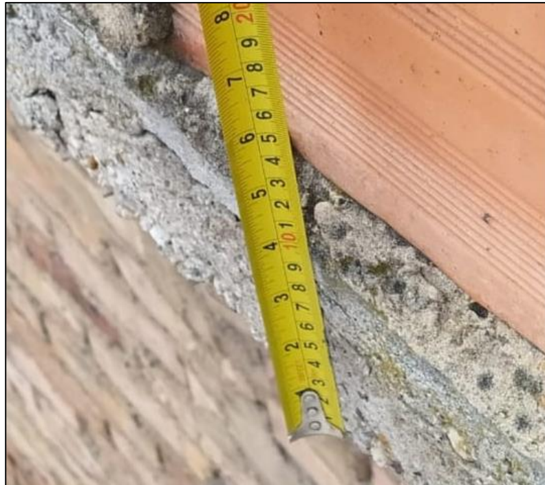
Ilustración 19. Medición altura de losa de cubierta
