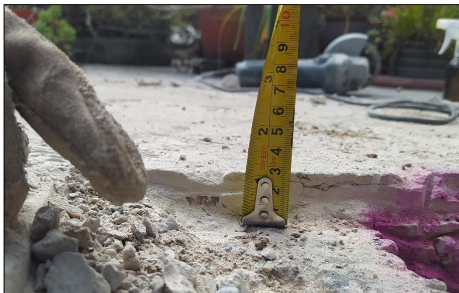
Ilustración 21. Espesor del mortero de nivelación. Fuente propia
