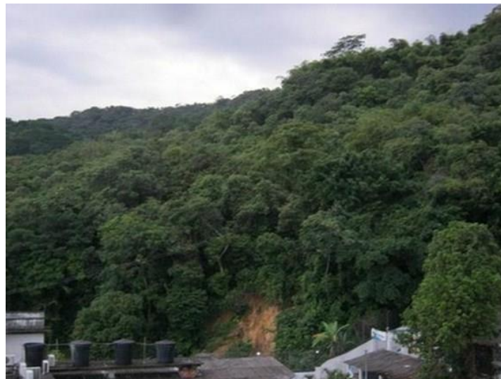
Figura 2-16. Deslizamiento Cerro Cristo Rey año 2013
