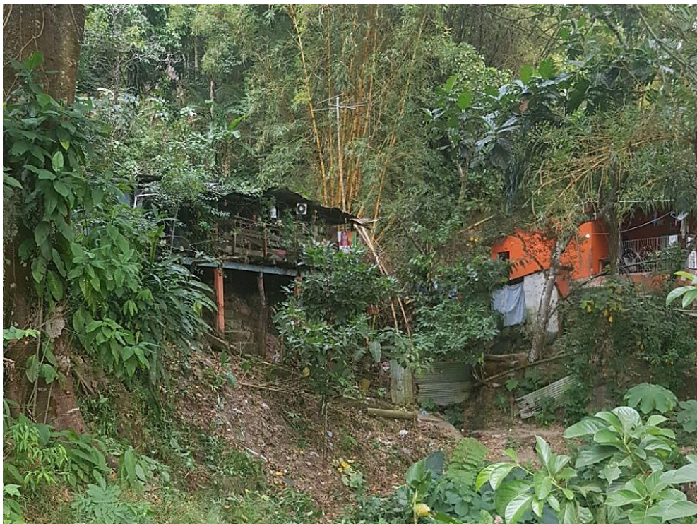
Figura 5-31. Aspecto de la remoción de masa en los asentamientos del barrio Colinas, en donde se observa bajo la casa el desprendimiento del suelo por efecto de los flujos de escombros, los cuales se incrementan en épocas lluviosas. Fuente: Autor
