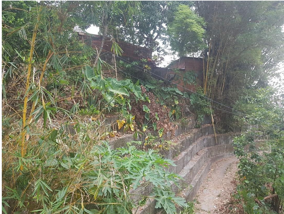
Figura 5-32. Muros de contención construidos para mitigar los efectos de la escorrentía superficial. Fuente: Autor
