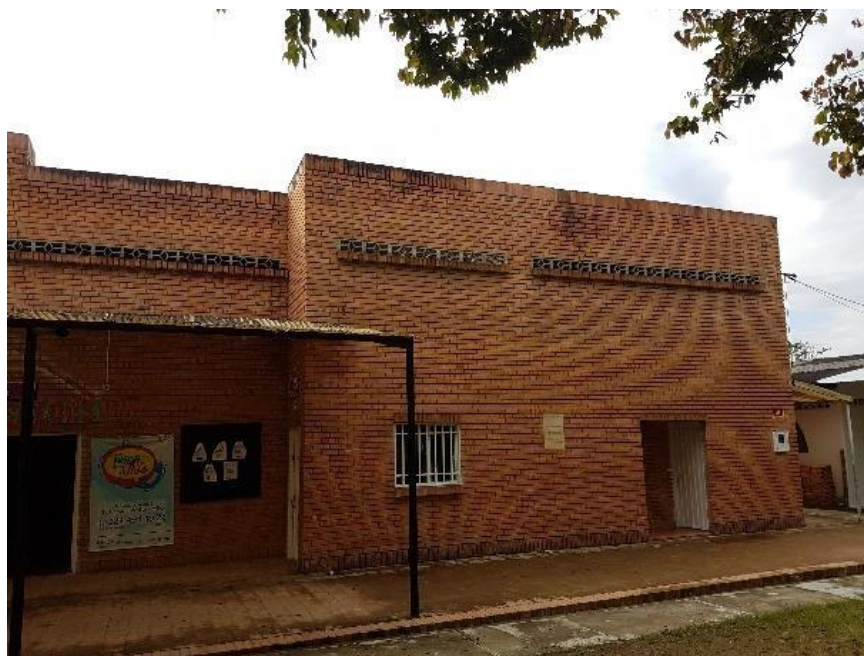
Gráfica 10 Fachada lateral Izquierda en mampostería a la vista. Fuente: Los autores.
