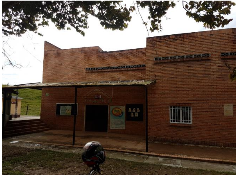
Gráfica 7: Fachada en mampostería a la vista. Fuente: Los autores.
