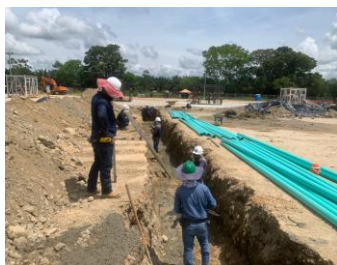
Photo 8: Excavación mecánica y manual para ductos enterrados.
