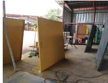
Photo 10: Construcción de tapas en laminas de alforaj.
