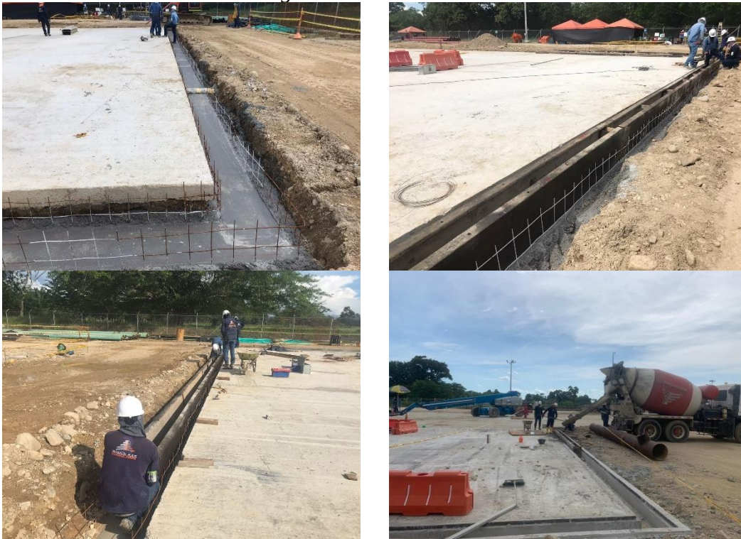
Figura 16. Construcción cunetas de aguas aceitosas
