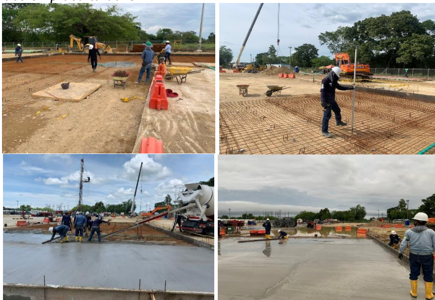
Figura 15. Construcción placa taladro
