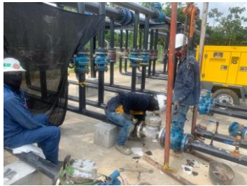
Photo 1: Conexión de línea de producción al manifold.
