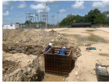
Photo 4: Instalación de formaleta y malla de caja de halado.
