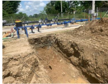
Photo 6: Excavación mecánica y manual para líneas de inyección.
