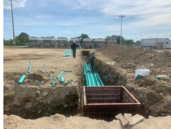
Photo 2: Instalación de tubería pvc conduit.
