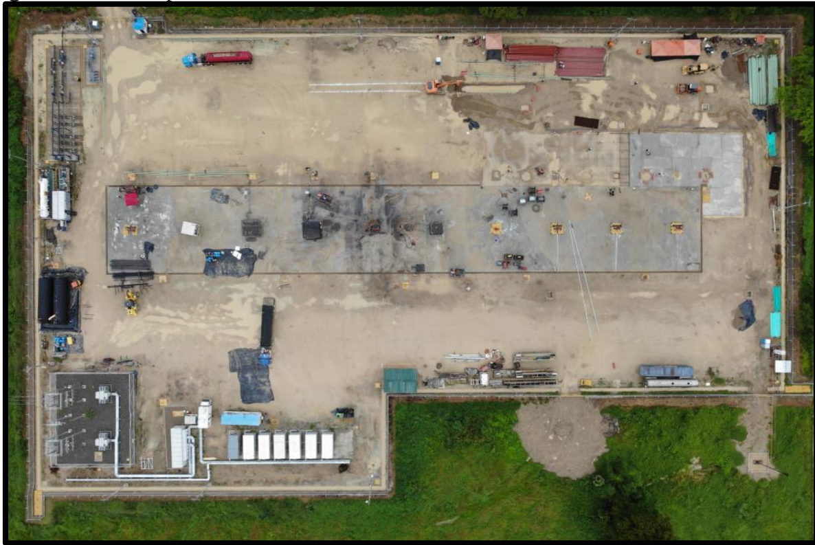
Figura 9. Locación pad SW
