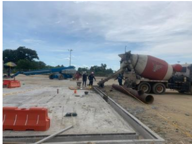
Photo 3: Fundida en concreto de carcamo perimetral
