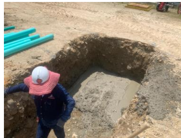
Photo 5: Fundida de piso de caja de halado.
