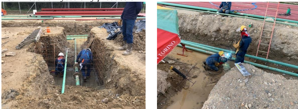
Figura 13. Líneas de inyección y producción
