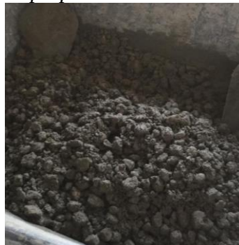
Figura 29. Materiales mezclados en la preparación del concreto.
