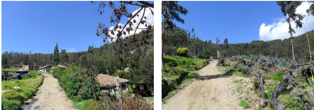
Ilustración 8. Estado actual de la vía cuatro copas
