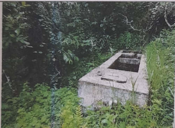
Desarenador en buenas condiciones de estructura, se debe mejorar el cerramiento e instalar tapas de protección de fácil operación y limpieza. No cuenta con tubería de bypass para actividades de mantenimiento.
