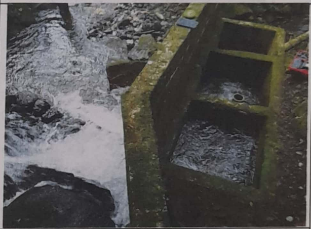
BOCATOMA QUEBRADA EL CIDRAL
