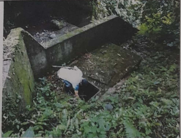
BOCATOMA QUEBRADA LOS LIRIOS
