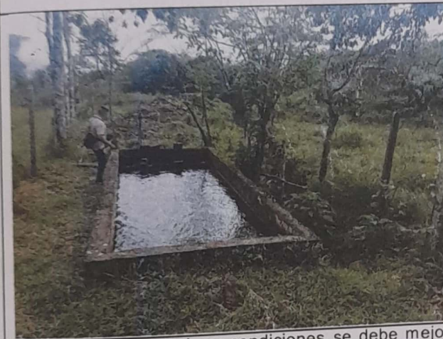
Bocatoma de fondo en buenas condiciones de estructura.
