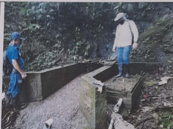
Bocatoma de fondo en regulares condiciones de estructura, caja de recolección y control de caudal necesita mantenimiento
