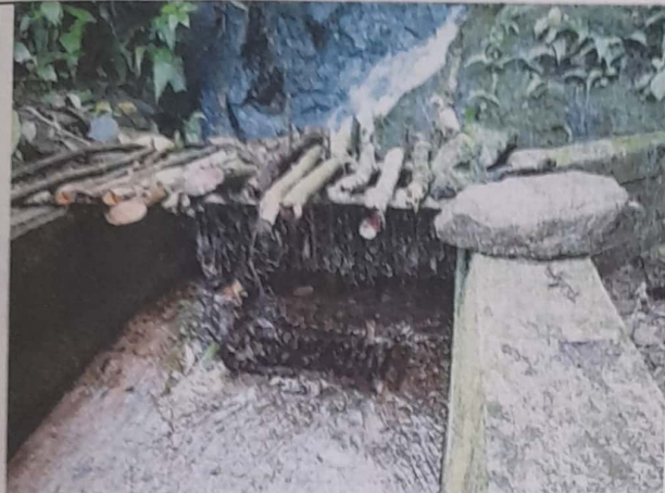
Bocatoma de fondo en regulares condiciones de estructura, caja de recolección y control de caudal necesita mantenimiento
