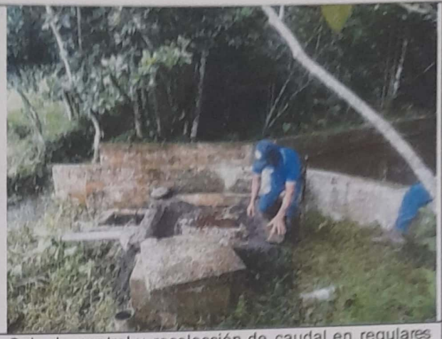
Caja de control y recolección de caudal en regulares condiciones
