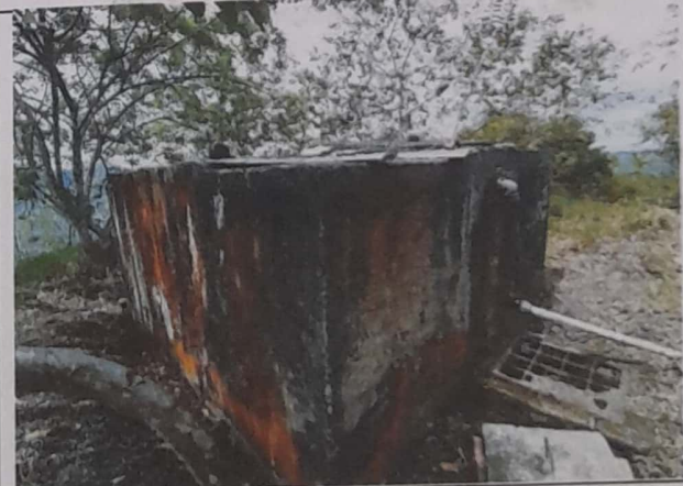
Tanques de almacenamiento en muy malas condiciones de estructura y mantenimientos preventivos, se encuentran sin tapas de protección
