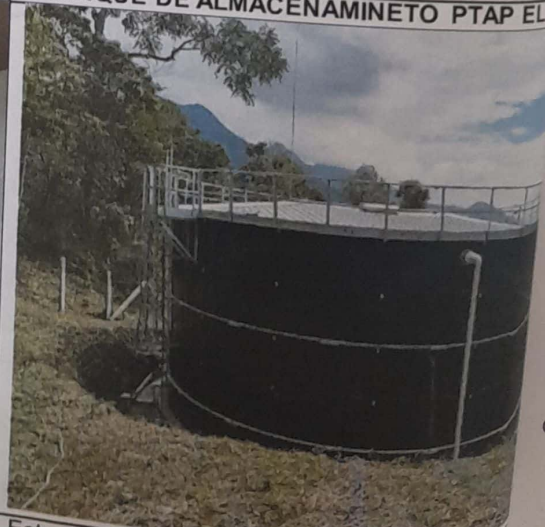
Estructura construida para almacenar 1200 m 3
