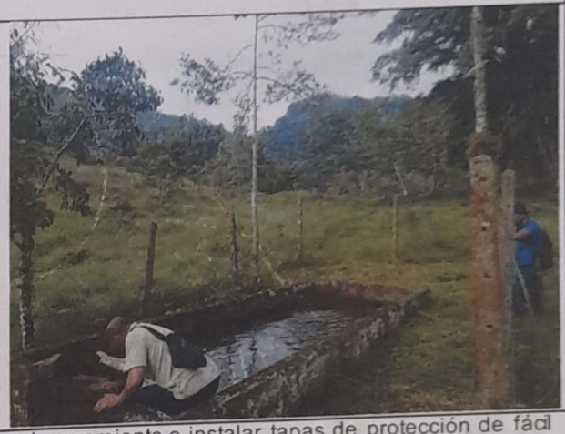
Caja de control y recolección de caudal en regulares condiciones
