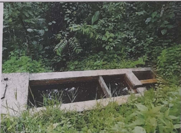
Desarenador en buenas condiciones de estructura, se debe mejorar el cerramiento e instalar tapas de protección de fácil operación y limpieza. No cuenta con tubería de bypass para actividades de mantenimiento.
