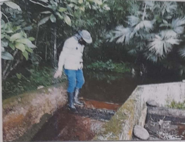
Bocatoma de fondo en buenas condiciones de estructura.
