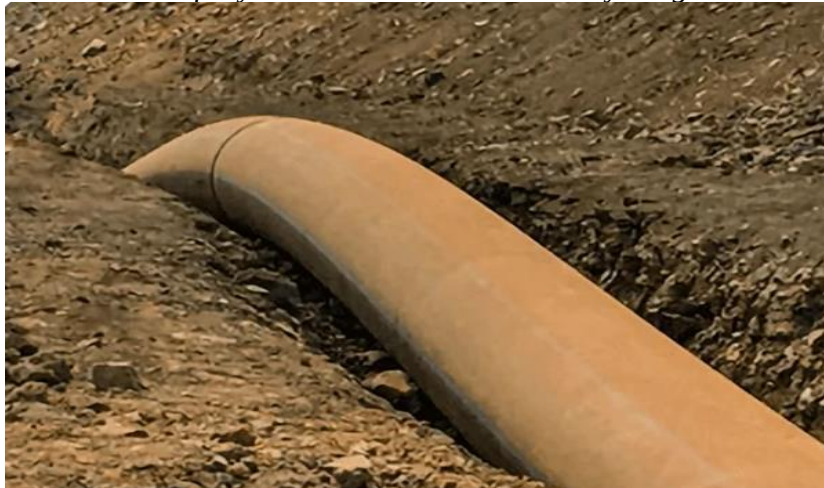
Figura 17. Tubería instalada en proyectos del sector de minería y dragado.
