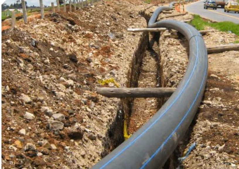
Figura 15. Tubería dirigida a obras de acueducto y alcantarillado.
