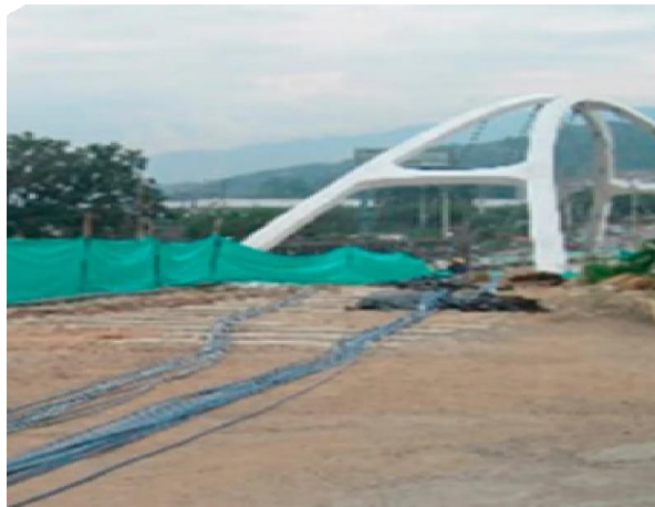
Figura 8. Tubería dirigida a obras civiles.
