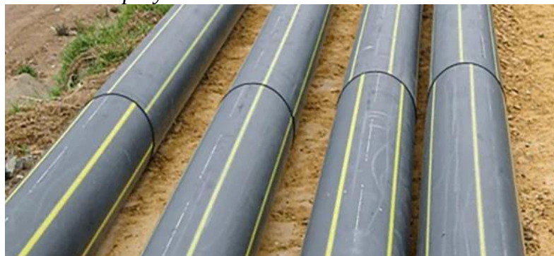
Figura 16. Tubería instalada en proyecto de relleno sanitario.
