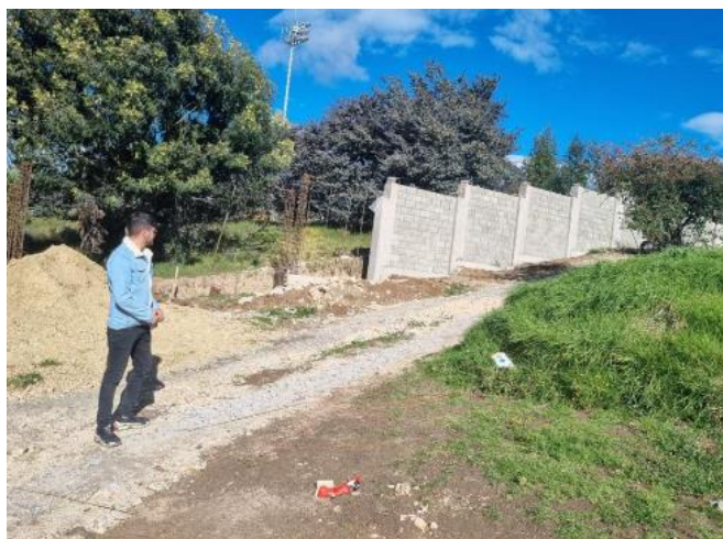
Figura 2. Apoyo en visita de inspección y control de obra al contrato de cerramiento con muro del colegio Silvino Rodríguez sede San Antonio (Tunja)
