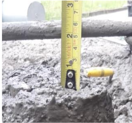
Fig. 7 ASENTAMIENTO DE LA MEZCLA CON 7% DE FIBRA APLICADA
