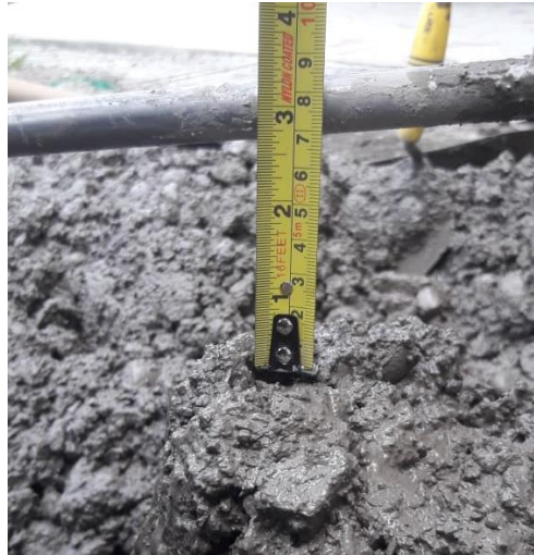
Fig. 5 ASENTAMIENTO DE LA MEZCLA CON 3% DE FIBRA APLICADA
