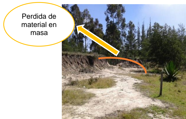
Fotografía 7. Problemas de remoción en masa doble calzada Bogotá- Sogamoso entrada del relleno.
