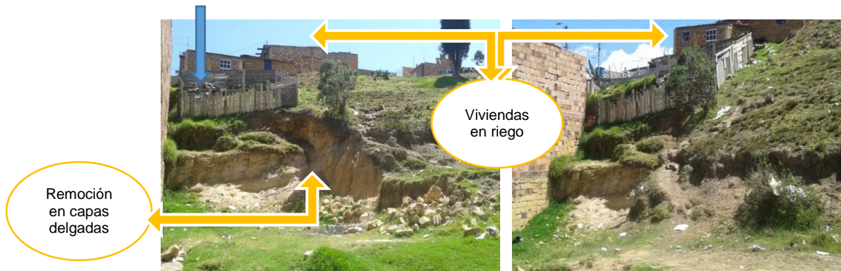
Fotografía 3. Perdida de zona urbana por problemas erosivos barrió el milagro.
